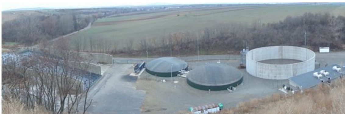
Obr. 12: Bioplynová stanice Bratčice v okrese Brno-venkov (Zdroj: STAVOS BRNO, A.S. Bioplynová stanice Bratčice. Stavos.cz [online]. ©2011 [cit. 2013-01-21]. Dostupné z: http://www.stavos.cz/bioplynova-stanice-bratcice/ )
