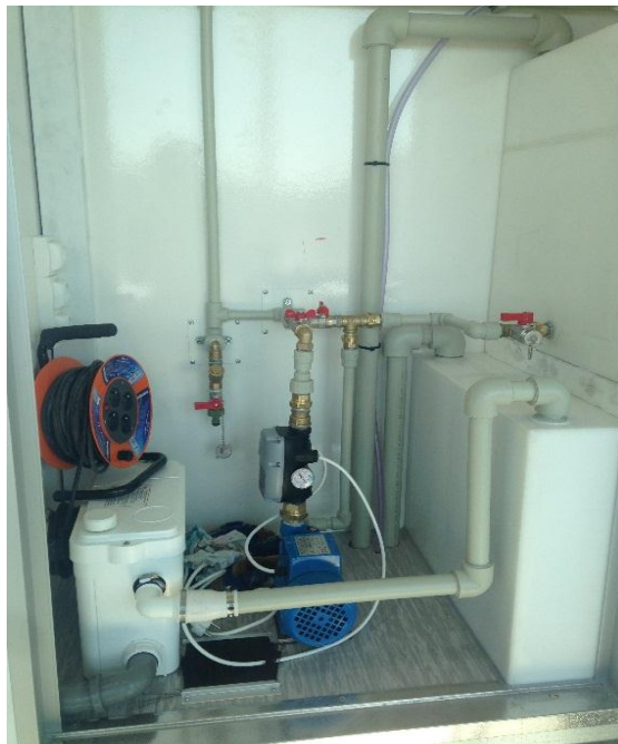
Obrázek 9: Elektroinstalace a vodoinstalace (Zdroj: Vlastní zpracování).
