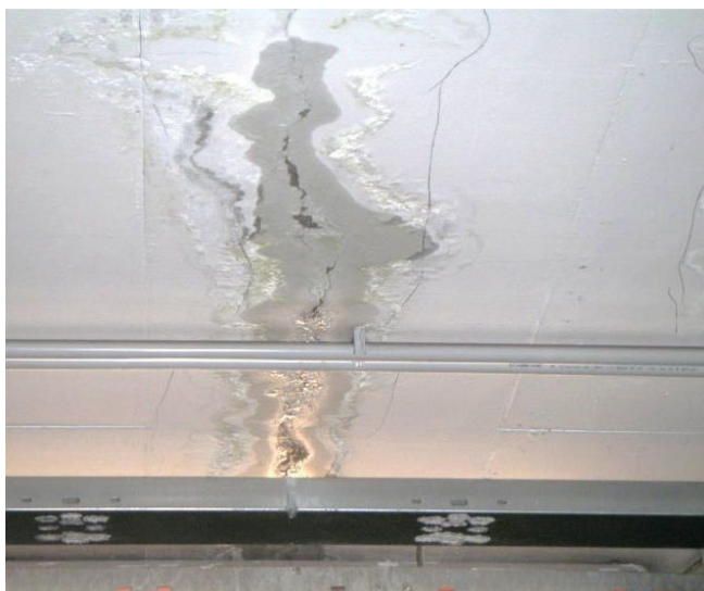
Obr. 4: Mezistropu hromadných garáží; průsaky trhlinami na podhledu
