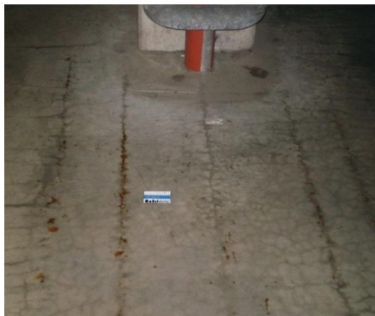
Obr. 7: Příklady rozvoje plošné koroze drátků, v kombinaci s přidávanými pruty betonářské výztuže v podporovém pruhu
