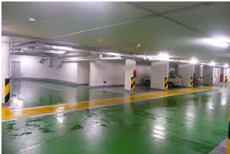
Obr. 2: Nevyspádované podlahy, tvorba kaluží v nižších patrech garáží
