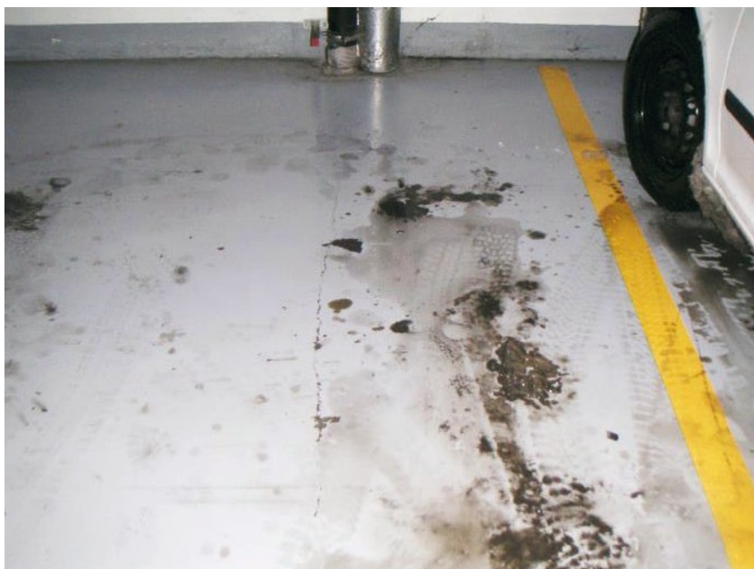
Obr. 1: Typický zimní stav podlahy – mezistropu hromadných garáží; louže na podlaze
