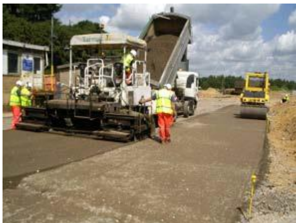
Obrázek 3 Pokládka a hutnění vrstvy [22]
