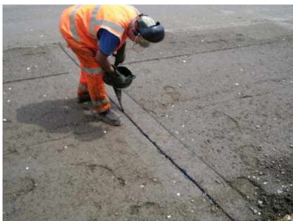
Obrázek 6 Utěsnění asfaltovou zálivkou [22]
