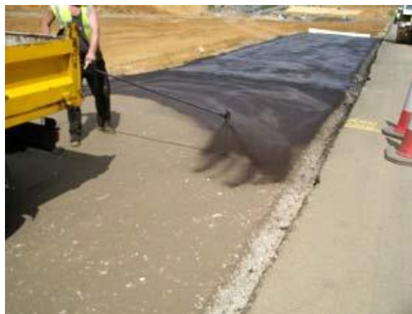
Obrázek 4 Nástřik asfaltové emulze [22]
