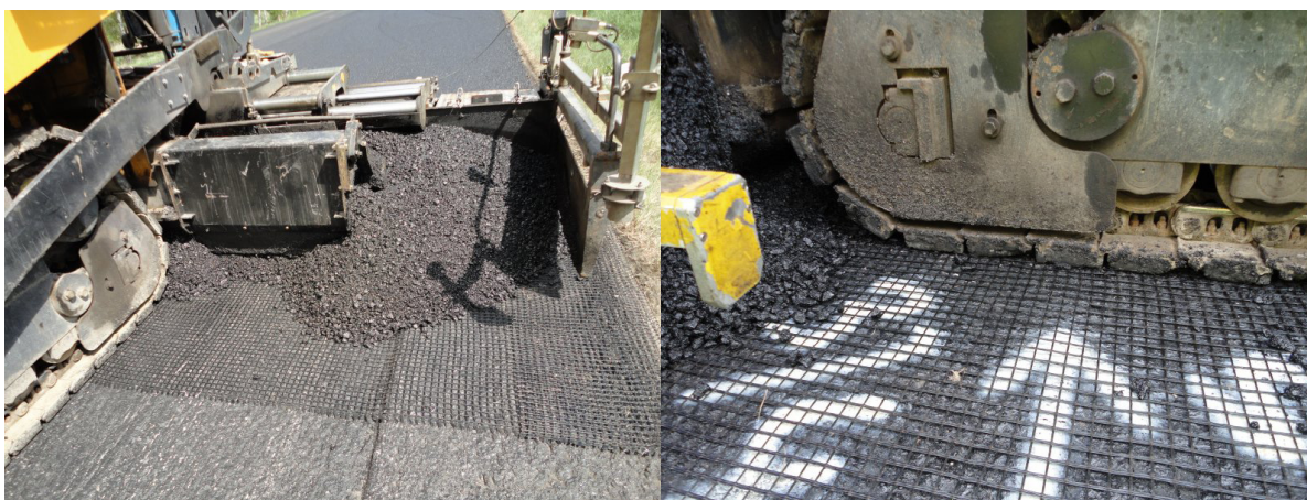
Obrázek 6: Způsob pokládky geomříže [18]
