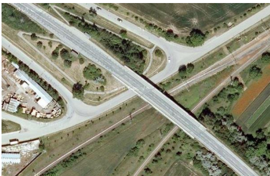
Obrázek 64 Most na silnici 50 hned za sjezdem z D1
