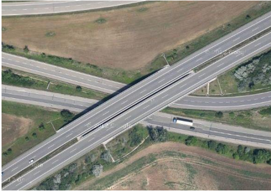
Obrázek 62 Podjezd na silnici R50
