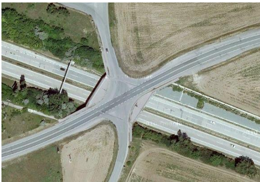
Obrázek 63 Podjezd na dálnici D1
