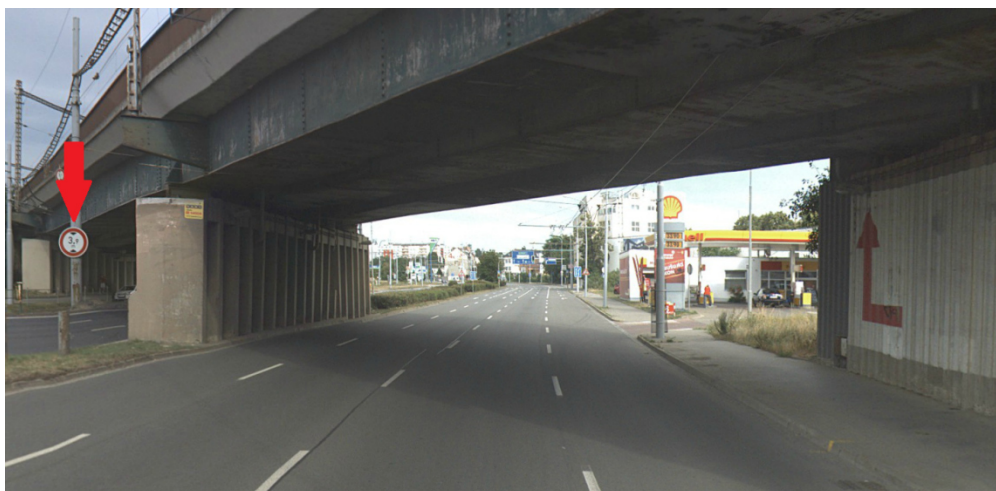
Obr. 26 - Podjezd pod železničním mostem na silnici I. třídy Olomoucká[4]
