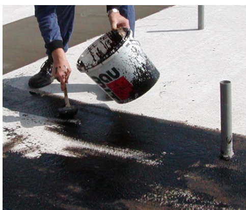
Obr. 55 - Provedení hydroizolace [11]
