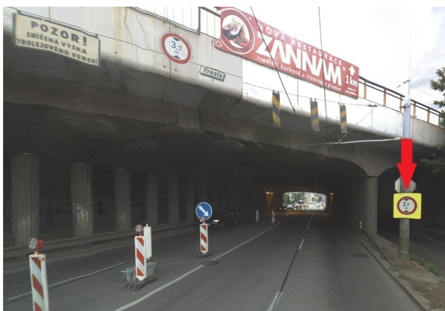
Obr. 27 - Podjezd pod železničním mostem na silnici I. třídy Svatoplukova[4]
