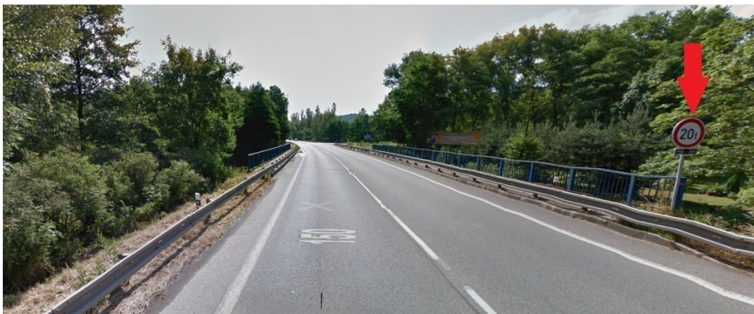
Obr. 29 - Přejezd mostu na silnici II. třídy 150[4]
