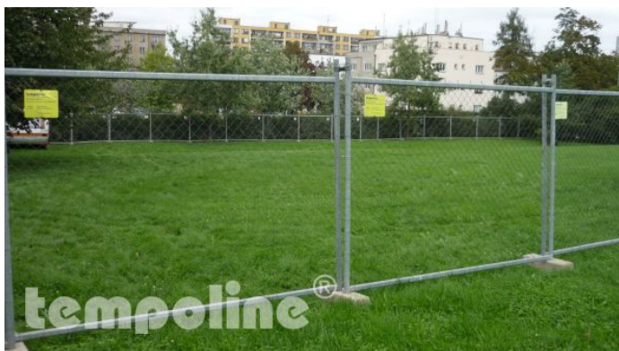
Obr. 88 - Oplocení zařízení staveniště[25]
