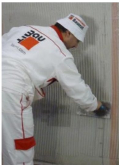
Obr. 148 - Uložení sklotextilní síťoviny[59]
