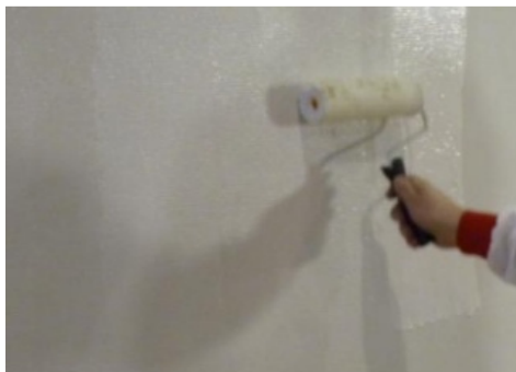
Obr. 149 - Provedení základního nátěru[59]
