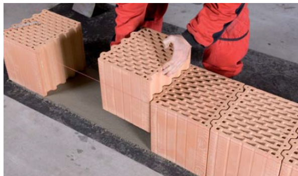
Obr. 59 - Položení první vrstvy zdiva [12]
