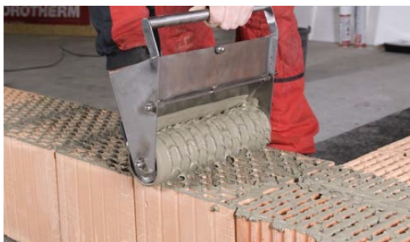
Obr. 60 - Nanášení malty pomocí válce[12]
