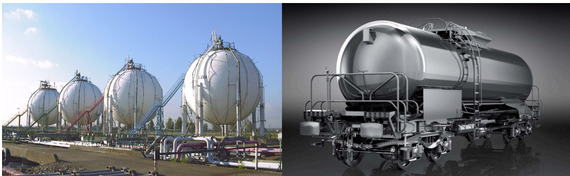
Obr. 2.1 Najpoužívanejšie druhy tlakových nádob (guľové, válcové), [3,2]
