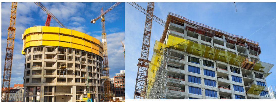
Obrázok 67 Ilustračný obrázok veterného štítu (16) a záchytných sietí
