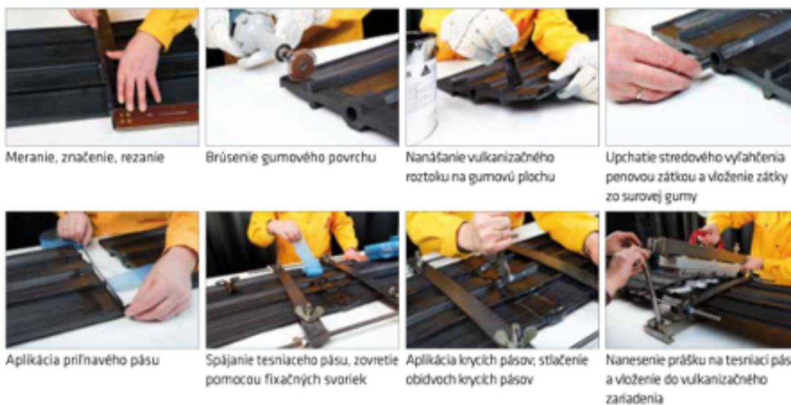
Obrázok 54 Spôsob rezania a zvárania tesniacich pásov (SIKA -tesnenie škár) (35)
