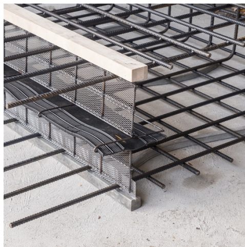
Obrázok 52 Umiestnenie pásu SIKA D v strede prierezu na pletive Frank (34)
