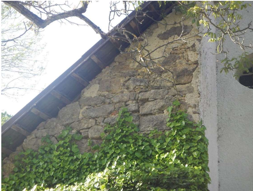
Obr. 10 – Chybějící omítka na jihovýchodním opěráku odhalující materiál zdiva. Fotografie z archivu autora bakalářské práce.
