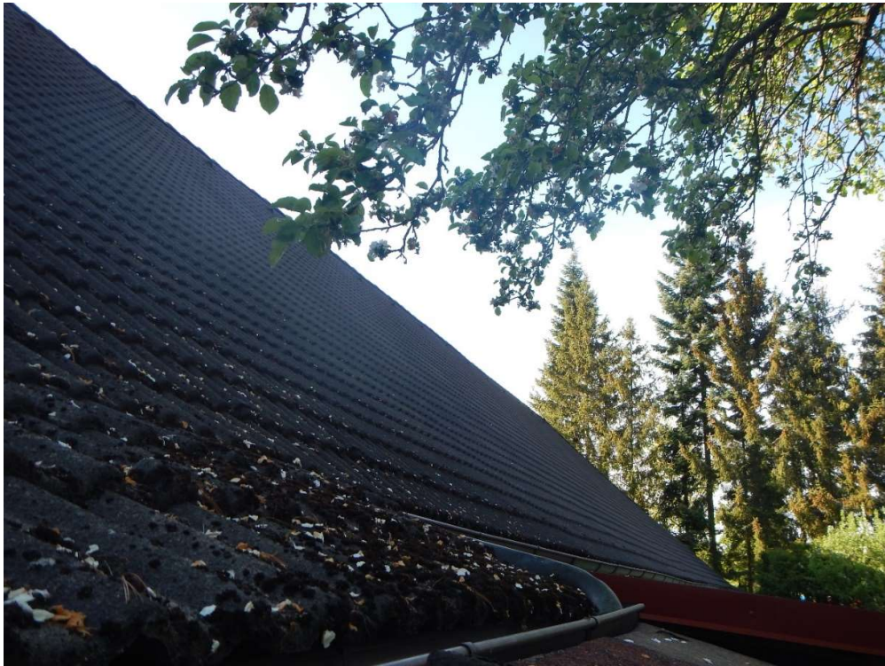
Obr. 17 – Pohled po střešní rovině bez výrazných viditelných nerovností. Fotografie z archivu autora bakalářské práce.
