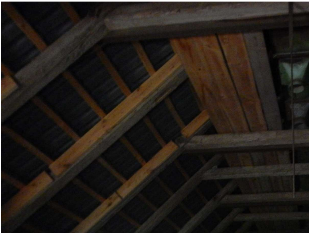
Obr. 18 – Vyrovnání některých krokví při rekonstrukci. Fotografie z archivu autora bakalářské práce.
