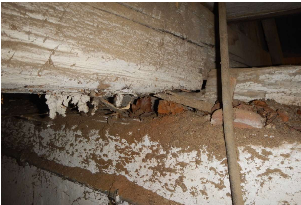
Obr. 27 – Místo spoje pozednice a stropnice před odkrytím nečistot. Fotografie z archivu autora bakalářské práce.
