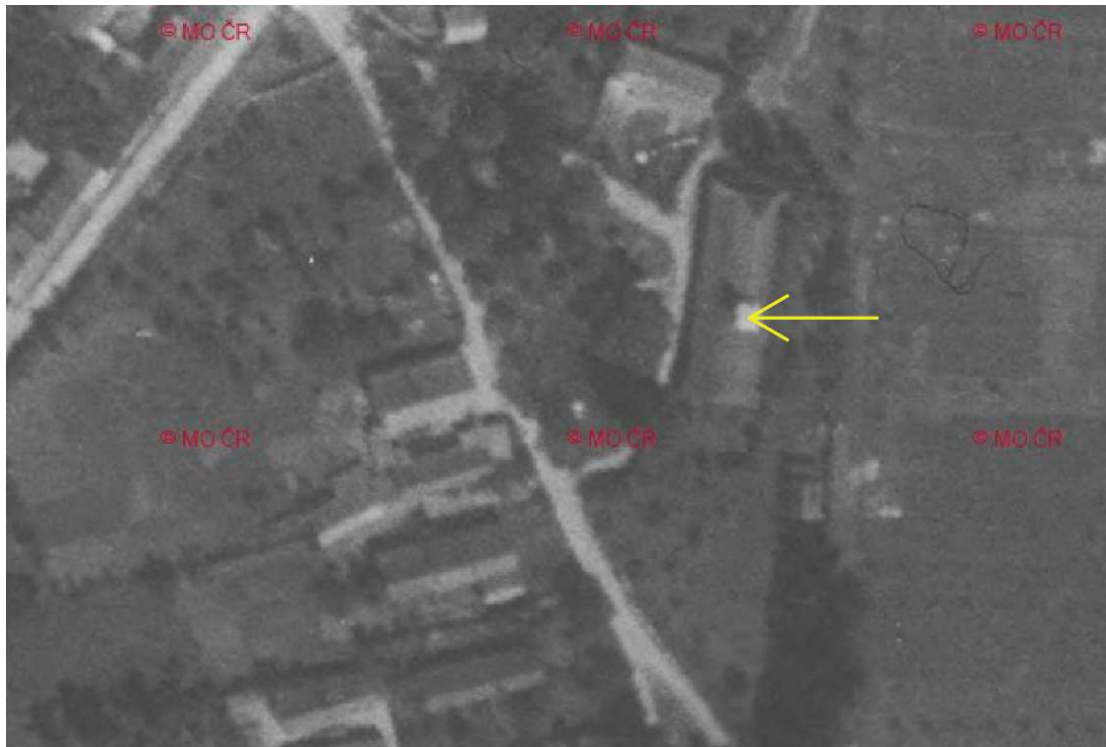
Obr. 5 – Objekt na leteckém snímku z roku 1953, šipka ukazuje na jasně patrné větrací zařízení. Střecha je již nepůvodní s keramickou krytinou (bobrovkou). Z okolí objektu vymizely některé stavby a les ustoupil. [9]
