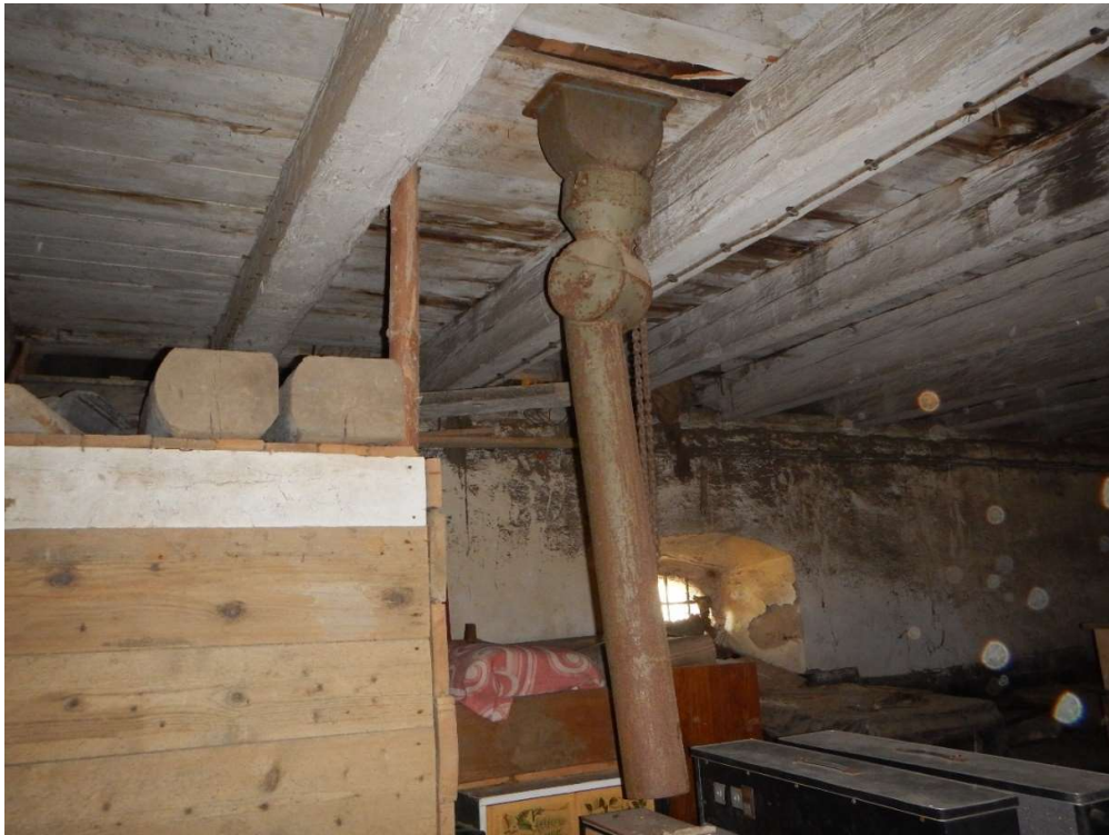
Obr.14 – Zachovalé šoupě. Fotografie z archivu autora bakalářské práce.
