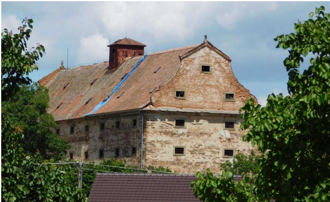
Obr. 6 – Barokní sýpka v Miroslavi z roku 1735, zachovalé větrací zařízení na střeše, podle vzhledu se jedná o typickou konstrukci, kdy se podobná zařízení dochovala na více objektech sýpek používaných během 20. století a téměř vždy se jedná o tento systém. [10]
