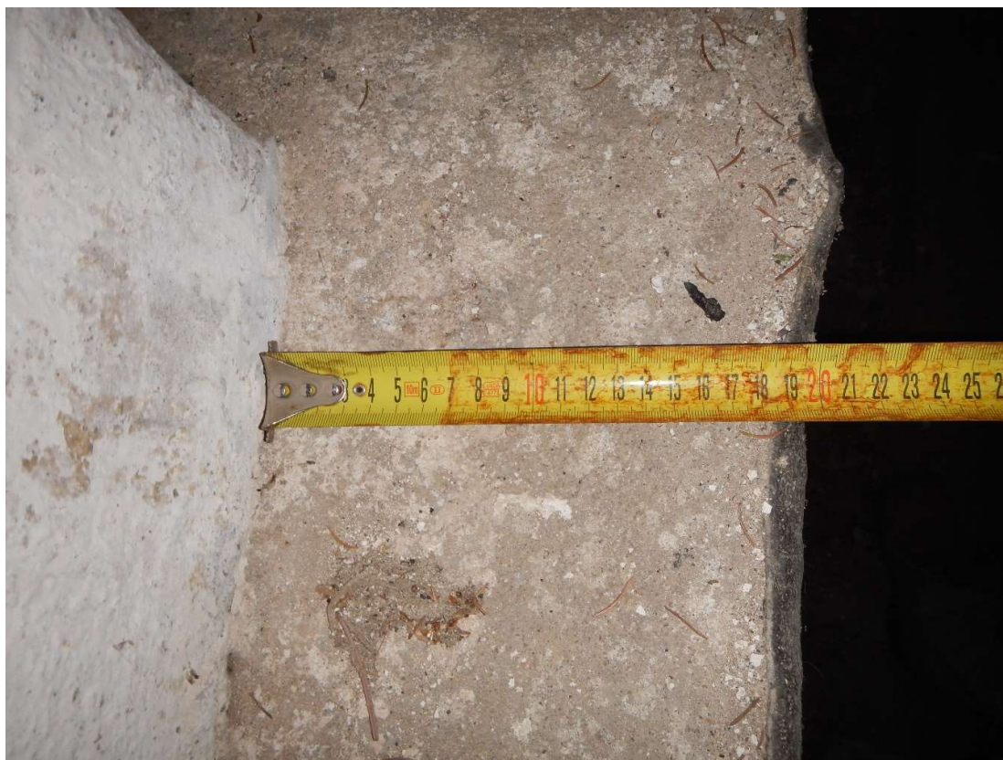
Obr.13 – Betonová přizdívka v nejširším místě. Fotografie z archivu autora bakalářské práce.
