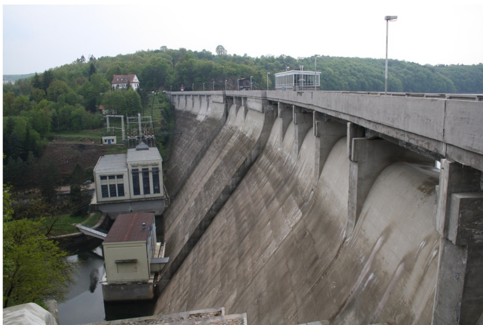
Obrázek 8 - Korunový bezpečnostní přeliv VD Vranov
