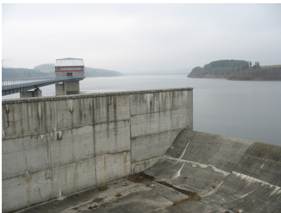
Obrázek 9 - Bezpečnostní přeliv na levém břehu VD Slezská Harta
