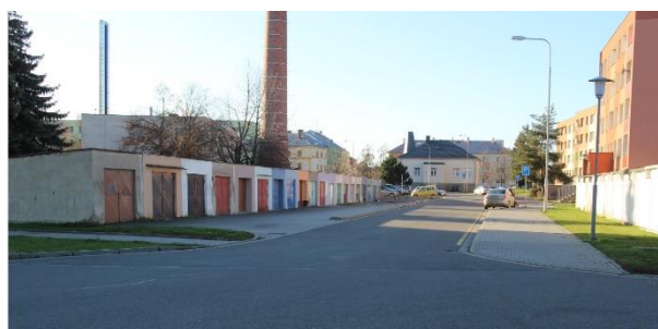
Obrázek č. 84: Řadové garáže na sídlišti Vítězná
