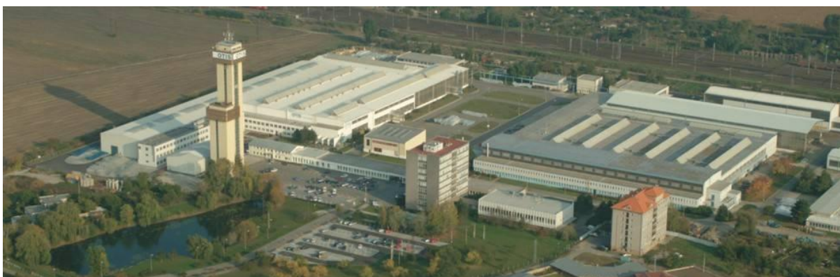
Obrázek 10: Areál divize Escalators OTIS a.s. v Břeclavi [9]
