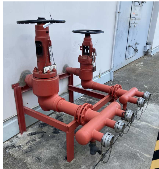
Obrázek 18: Příklad přípojného místa pro doplňování paliva dieselgenerátorů na ETE.
