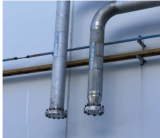
Obrázek 7: Přípojně místo na chladicí okruh reaktoru na ETE.
