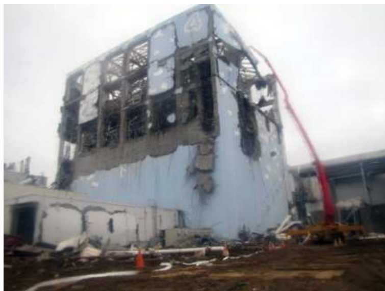
Obrázek 3: Putzmeister M58-5 čerpá vodu do SFP 4. bloku, převzato z [21].
