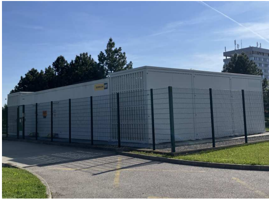
Obrázek 19: Dieselgenerátor na ETE.
