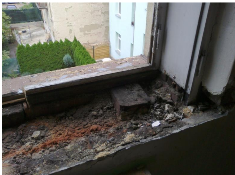
Obr. 18 Demontáž okenního rámu
