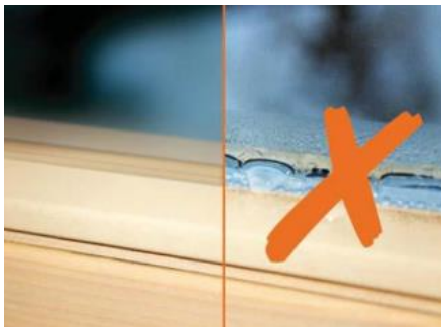
Obr. 3 Detail rosení okna
