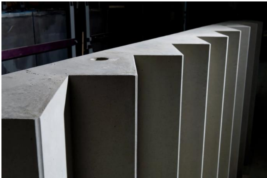
Obrázek č. 22: Betonové schodišťové rameno
