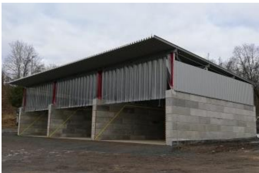
Obrázek č. 25: Koje vystavěné z Rieder – Bloc systémů
