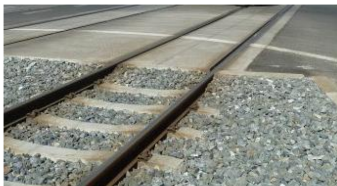
Obrázek č. 27: Přejezdová konstrukce Rieder – Tram
