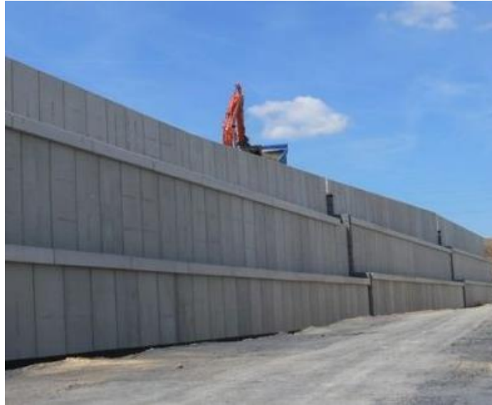
Obrázek č. 26: Konstrukce GeoWall
