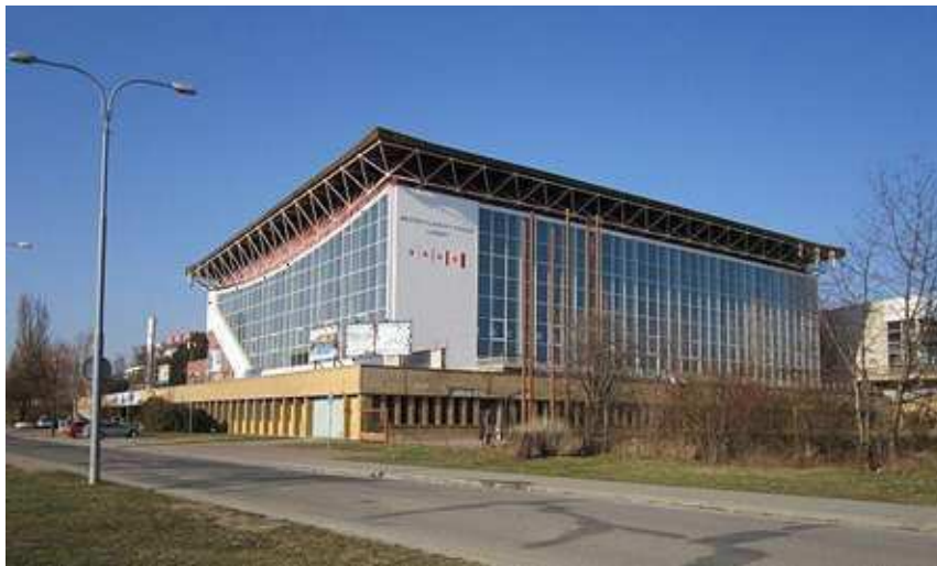
Obr.7.2 Plavecký bazén za Lužánkami [53]
