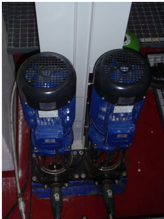
Obr.6.6 Čerpání vyčištěné vody [33]
