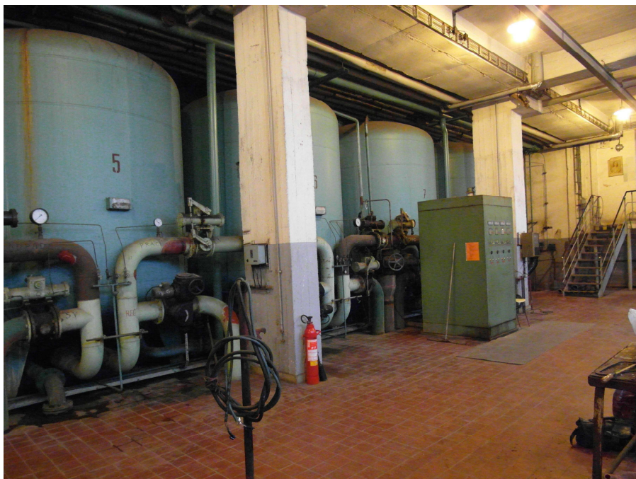
Obr.7.6 Písková filtrace
