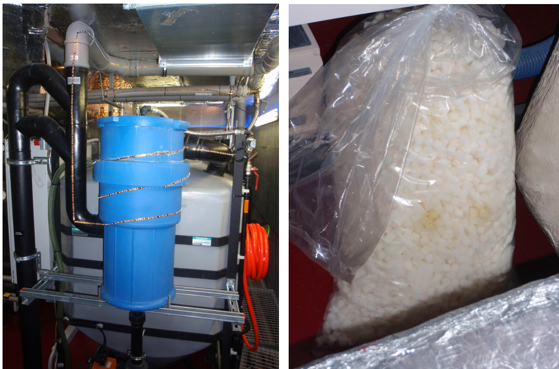
Obr. 6.5 Filtrace k zachycení hrubých nečistot [33]
