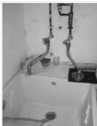
Obr.6.2 Možnost přívodu bílé vody zvláštní vodovodní baterii [30]
