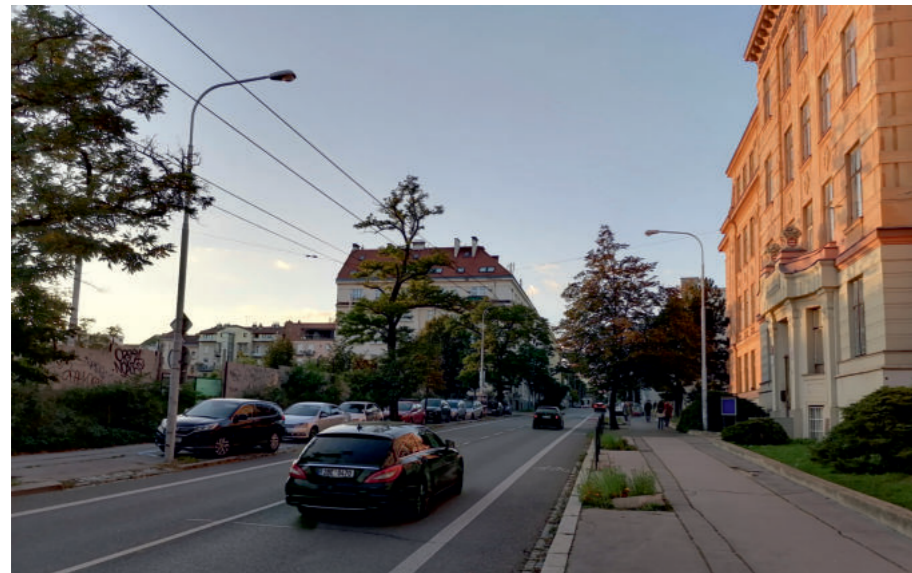
Pohled na nedostavěný blok od bývalé elektrotechnické průmyslovky na Kounicově ulici [foto autora]
