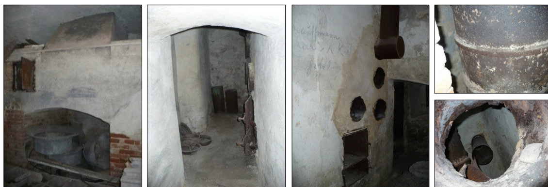
Obr. 5.2.2.21 Zámek Lednice 1.PP V-křídlo – dochované pozůstatky zděných pecí a kanálů pro rozvod teplého vzduchu, pod klenbou jsou nádoby na popel (zcela vlevo), boční pohled na příkladací a vybírací otvor topeniště s dochovanými dvířky (uprostřed vlevo), čelní pohled na
