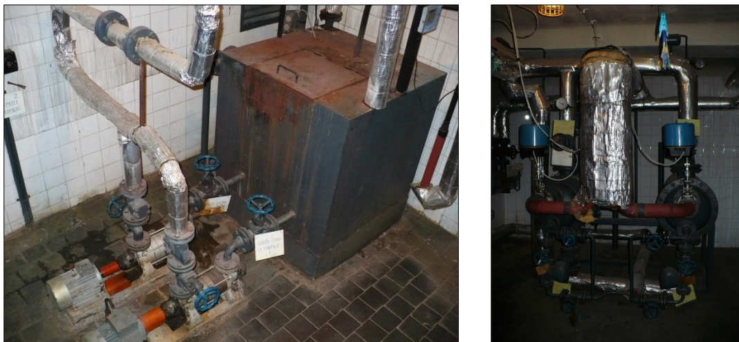
Obr. 5.2.2.29 Výměňková stanice CZT ve vile Tugendhat před památkovou obnovou – pohled na ležaté trubkové výměníky pára-voda (vpravo), nádrž na kondenzát a kondenzátní čerpadla (vlevo) [zdroj: autor]
