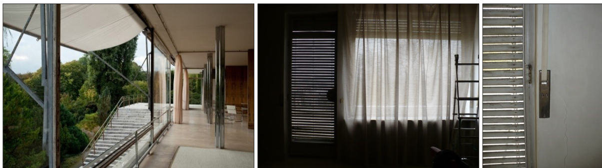
Obr. 5.2.2.31 Stínící prvky ve vile Tugendhat – látkové markýzy nad JZ okny obytné haly (vlevo) [zdroj: David Židlický [18]], vnější dřevěné žaluzie ve 2.NP – pokoj paní (uprostřed), detail ovládání žaluzií (vpravo) [zdroj: autor]
