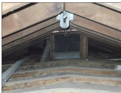
Obr. 5.2.2.3 Krov nad Zámeckým palmovým skleníkem – detail kladkového mechanismu, který ovládá víko nad větracím otvorem ve stropě [zdroj: autor]
