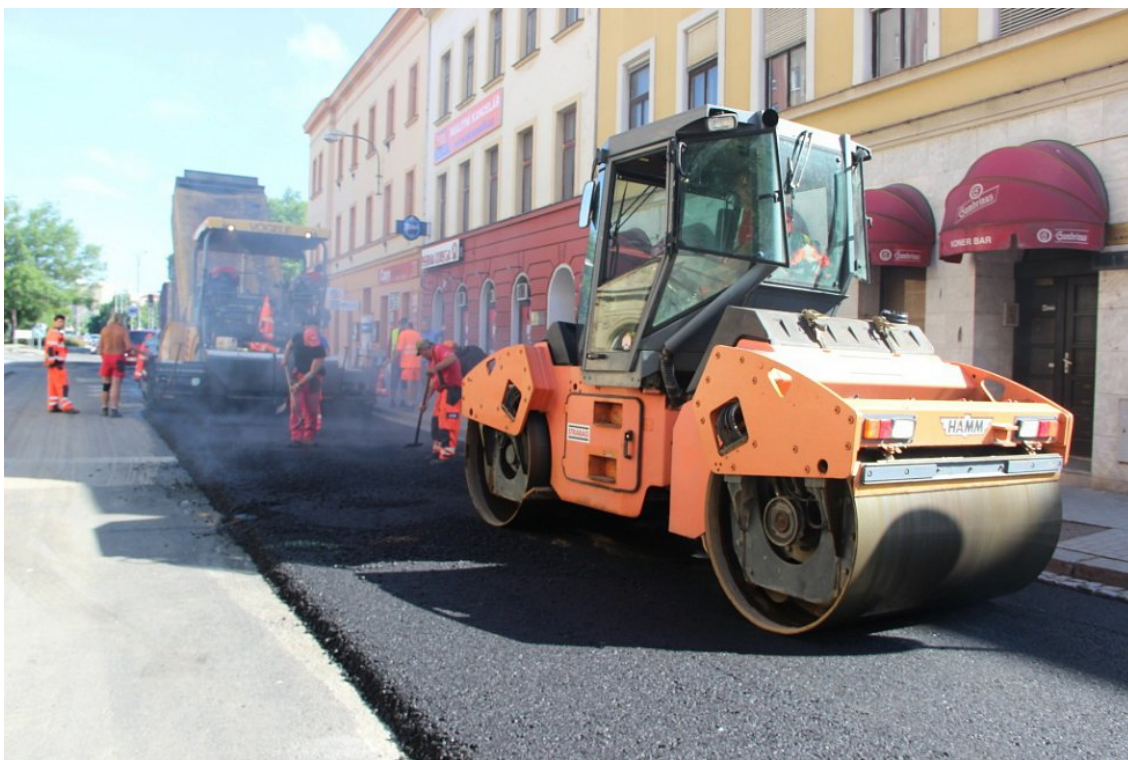
Obrázek 2: Výpary při pokládce asfaltové směsi [40]
