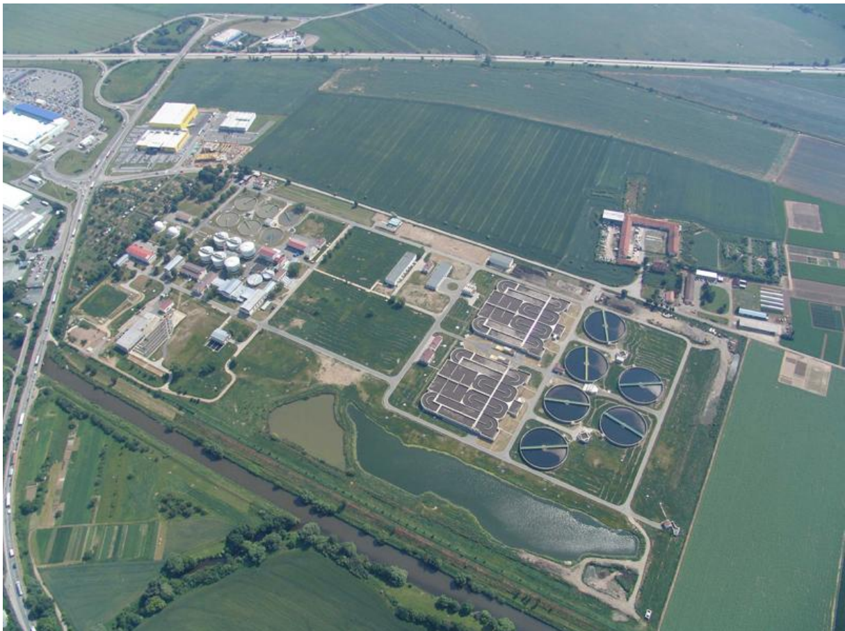
Obrázek č. 12: Letecký pohled na velkokapacitní čistírnu odpadních vod Brno – Modřice [37]
