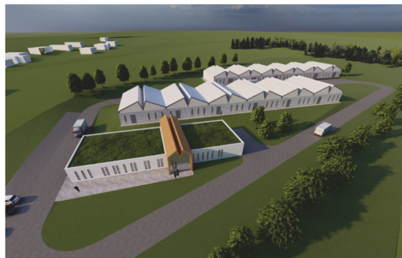
Obrázek 6 – Návrh areálu pro malé a střední podnikání ve Víchově, Anna Žůrková II. ročník Bc. studia architektury (zdroj: autorská vizualizace [5])
