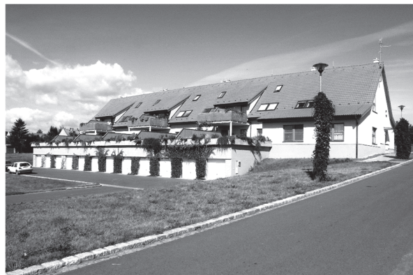
Obrázek 11 – Bytový dům Slatinice, rekonstrukce typového krávinu K 96 (zdroj: autorská fotografie Jan Synek)
