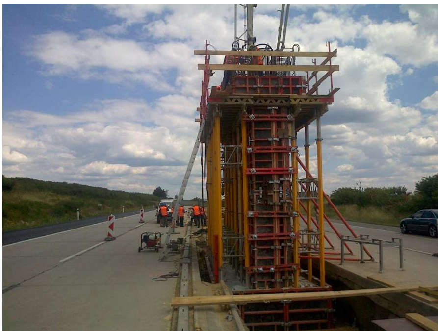
Obr. 6-5 Fotodokumentace D1 úsek 21 – etapa 2, betonáž pilíře v SDP, zdroj vlastní
