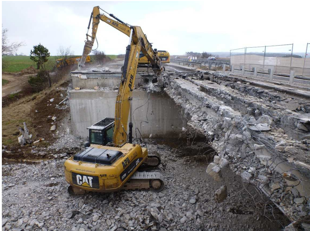
Obr. 6-7 Fotodokumentace D1 úsek 2 – etapa 4, demolice mostu SO203, zdroj vlastní
