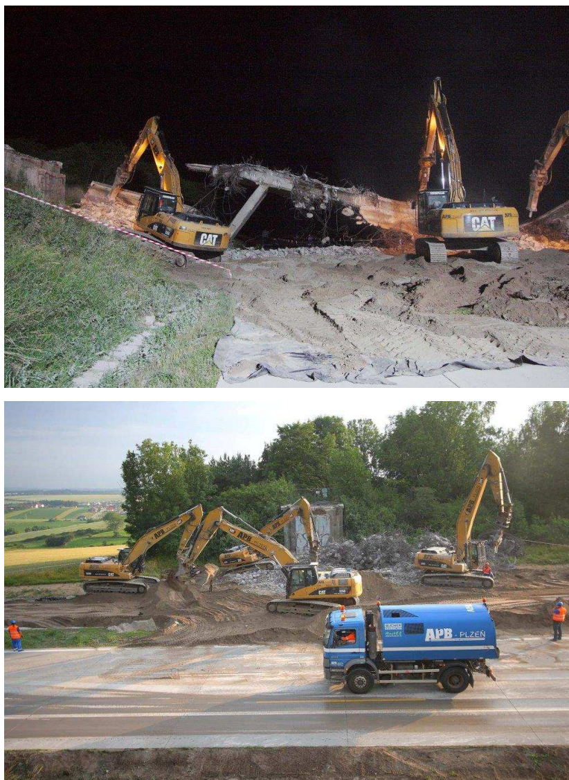
Obr. 6-3 Fotodokumentace D1 úsek 21 – etapa 1 demolice nadjezdů, zdroj vlastní
