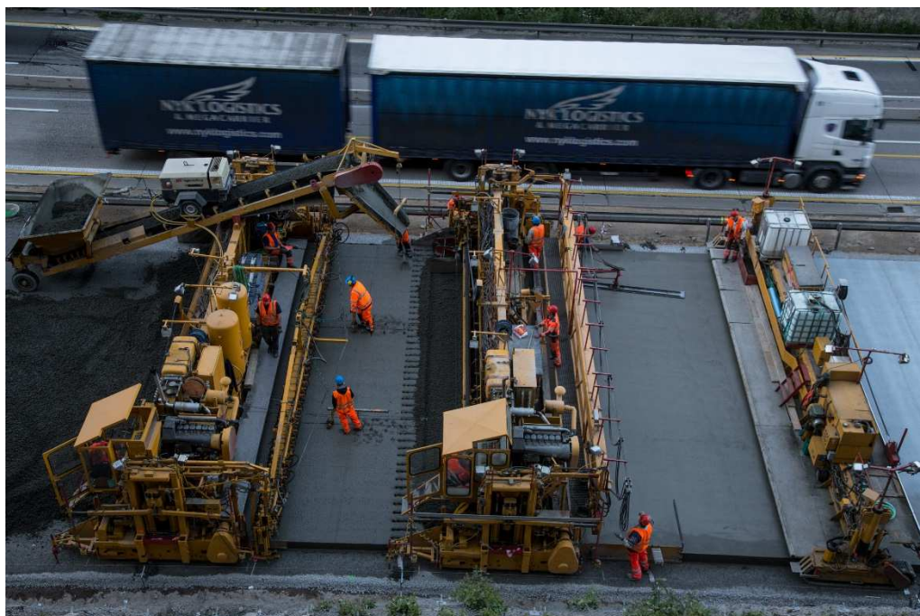
Obr. 6-6 Fotodokumentace D1 úsek 21 – etapa 3, pokládka CB krytu, zdroj vlastní
