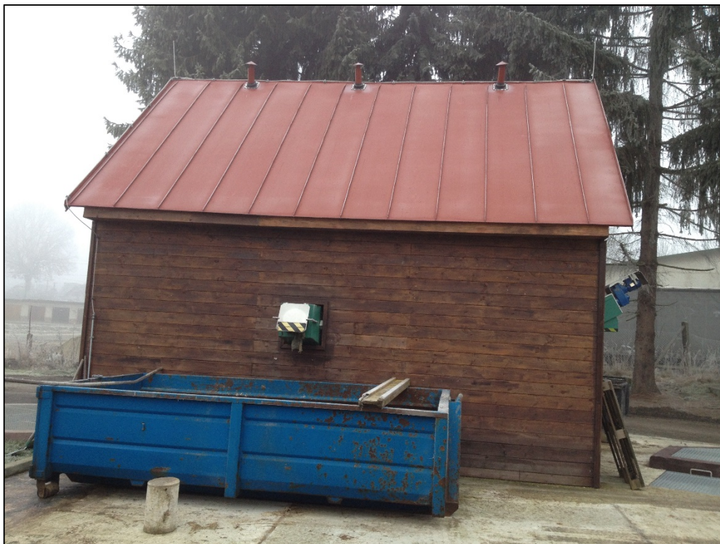
Foto 1 Objekt mechanického předčištění
