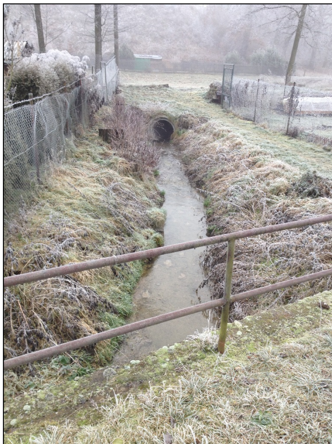
Foto 12 Odtok z odlehčovací komory
