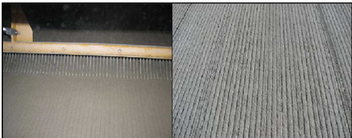
Obr. 19 Povrch vozovky texturovaný speciálními hráběmi [8]
