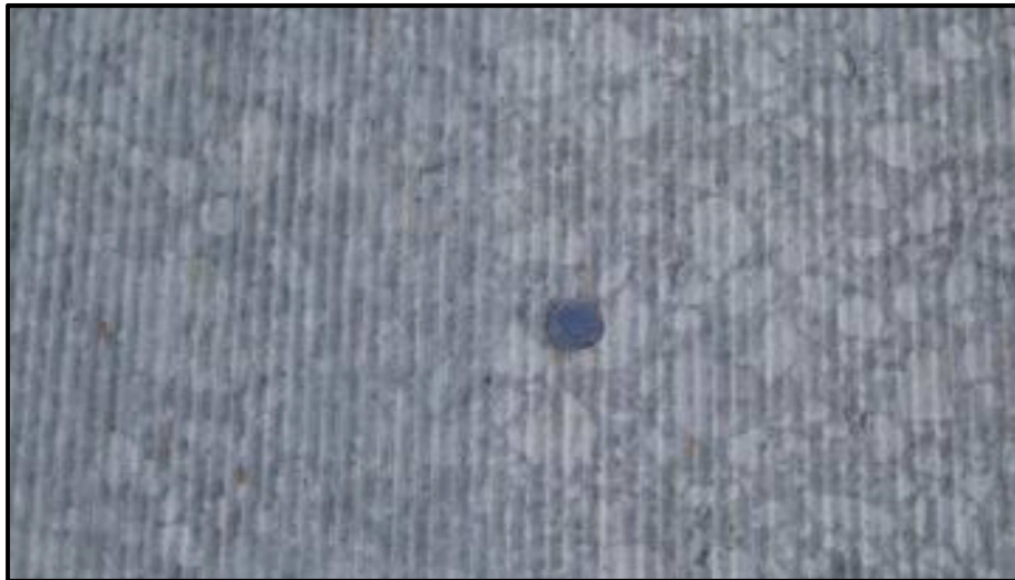
Obr. 18 Cementový kryt s výbrusy [5]
