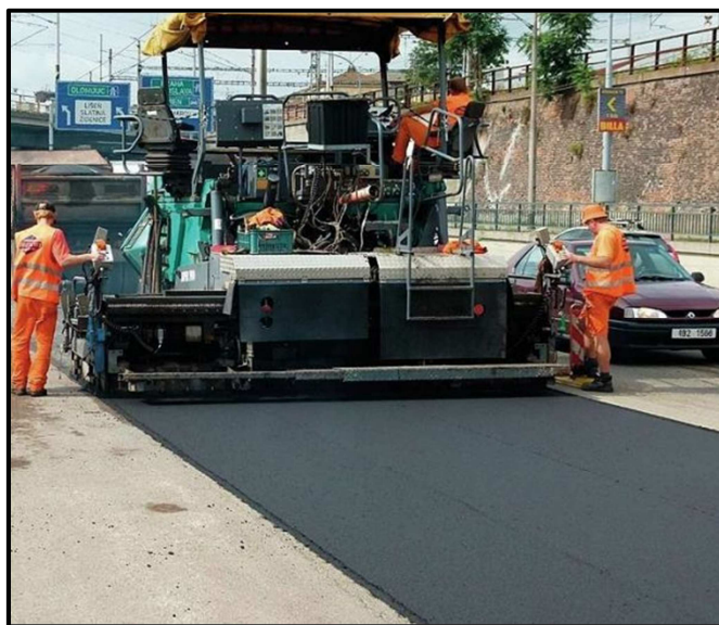
Obr. 25 Asfaltová směs modifikovaná pryžovým granulátem, ul. Koliště, Brno [13]
