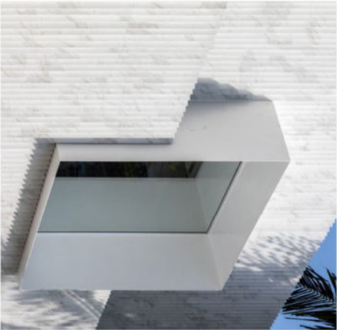
HLINÍKOVÉ OKENNÍ OSTĚNÍ, BARVA DLE RAL 8024 HNĚDÁ
