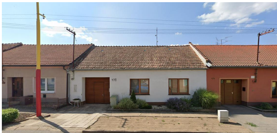
Obrázek 12: Pohled na přední část objektu před požárem [13]
