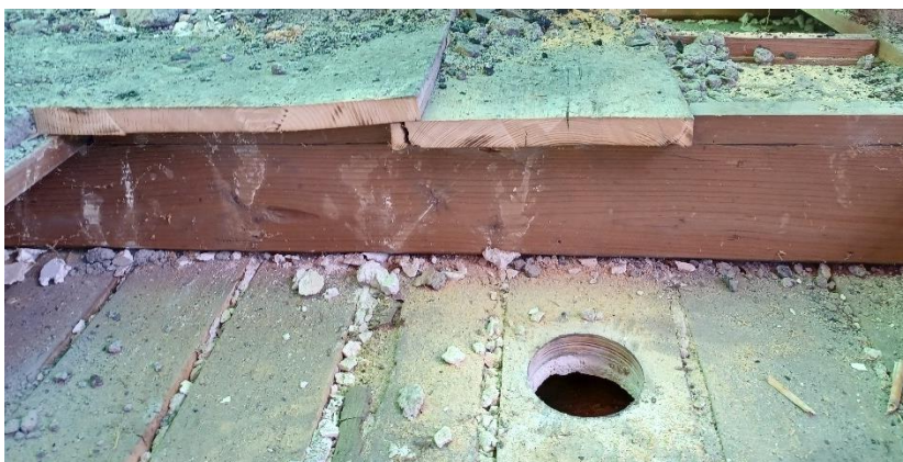
Obrázek 33: Ukázka prostřídání dřevěného záklopu s vrtem
