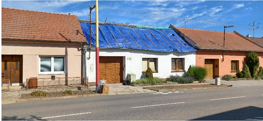
Obrázek 13: Pohled na přední část objektu po požáru
