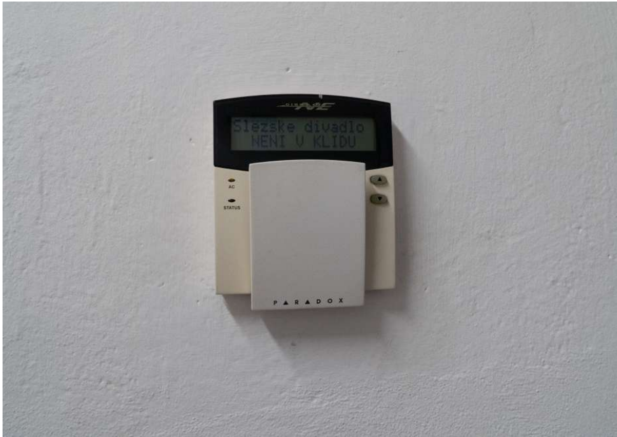
Obr. 9. - Konzola bezpečnostního systému Slezského divadla Foto Viliam Šebora
