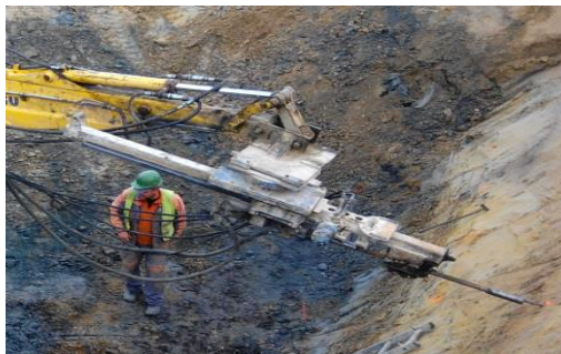
Obr. 49 - Stroj pro hřebíkování Morath [33]
