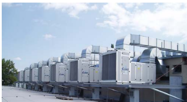
Obrázek 5 Tepelné čerpadlo vzduch - vzduch
