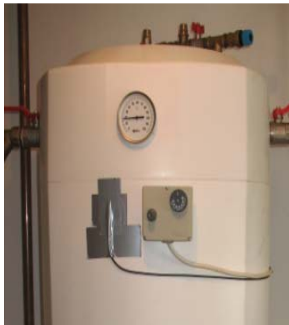
Obrázek 20 Akumulační nádoba s čidlem teploty
