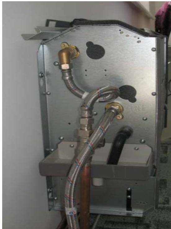
Obrázek 24 Napojení a odvod kondenzátu fan coilu
