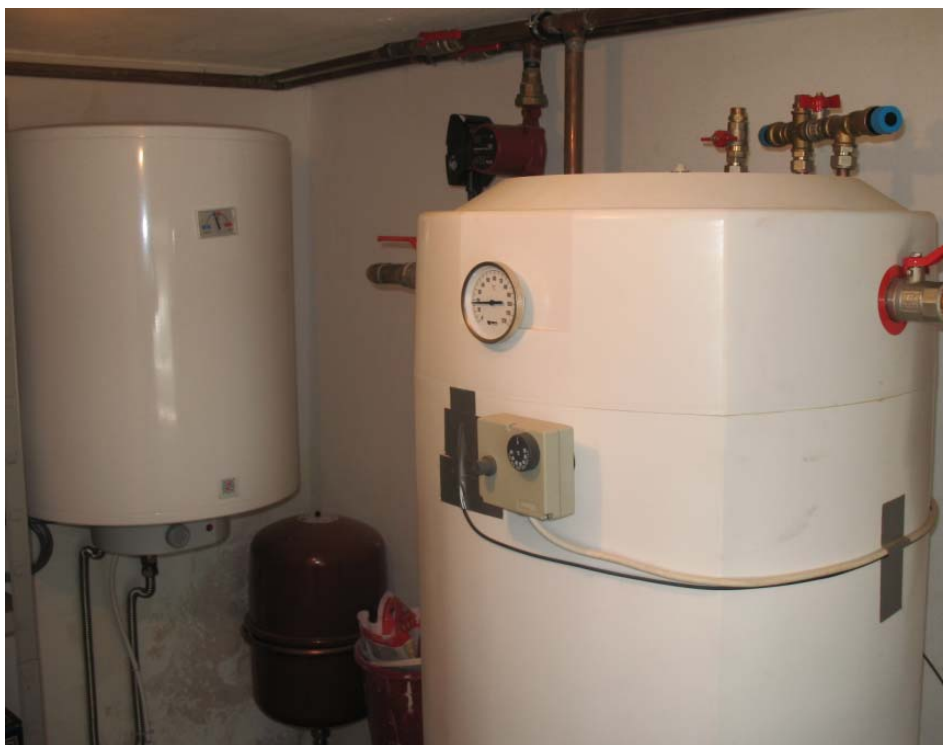
Obrázek 18 Akumulační nádoba, eltrický bojler, expanzní nádrž
