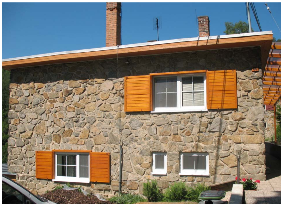
Obrázek 13 Rodinný dům v obci Skryje 31, východní pohled
