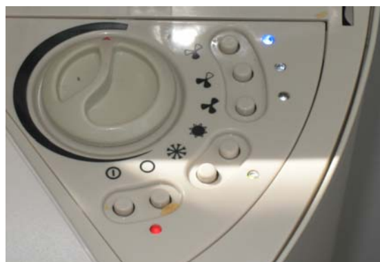
Obrázek 22 Ovládání fan coilu
