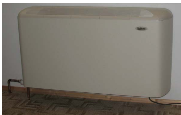
Obrázek 21 Fan coil
