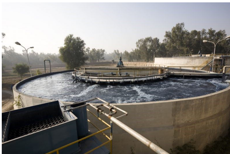
Obrázok 8: Aerovaná nádrž s aktivovaným kalom [51].
