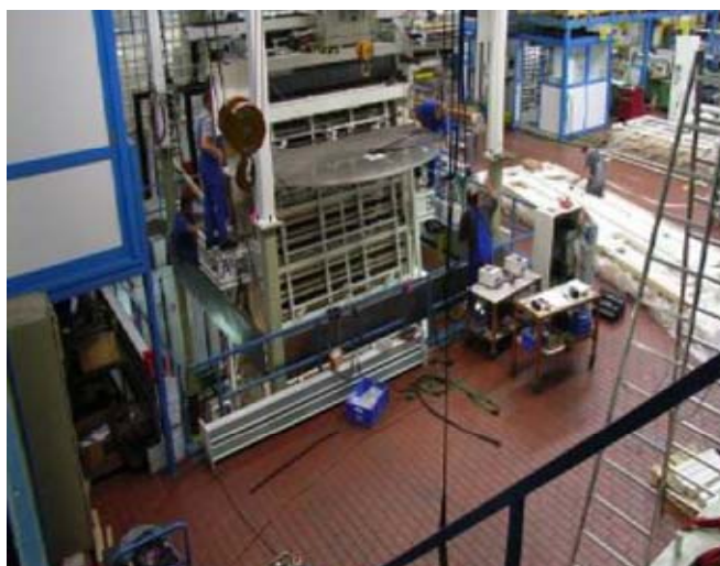
Obr. 3.13 Montáž podlážky stroje
