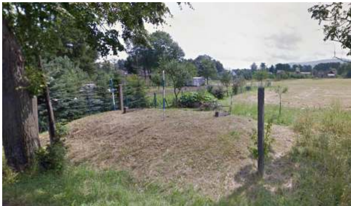
Obr. 3.3 Napojovací šachta RVS Hnojník na OOV – šachta Š – pohled ze silnice 4761
