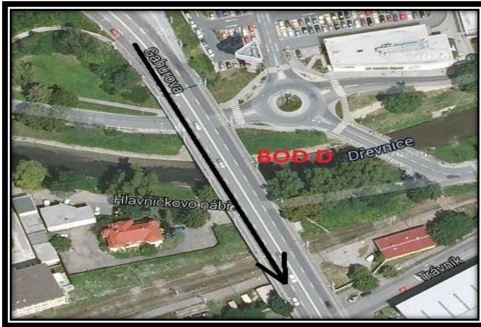
Obrázek 13 - Most přes řeku Dřevnice
