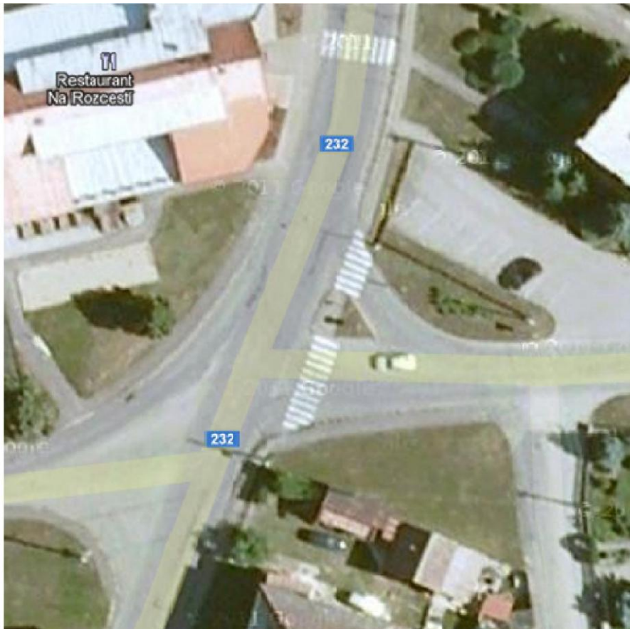
Obr. č. 15 – Stávající stav kritického místa č. 3 - detail
