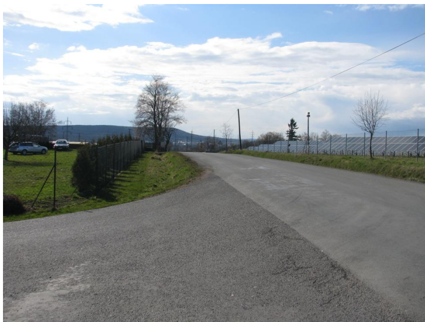
Obr. č. 21 – Stávající stav kritického místa č. 5 – levostranný rozhled na silnici III/11724
