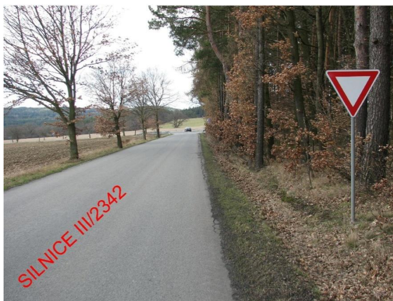
Obr. č. 9 – Pohled na kritické místo č. 2, směrem od Sírě
