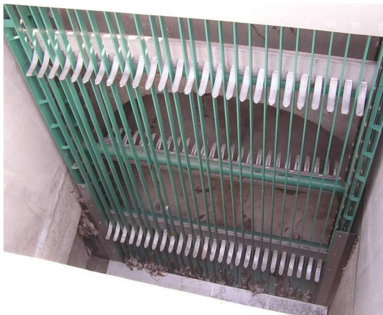
Obr. 2 Střední spodem stírané česle FONTANA R [4]
