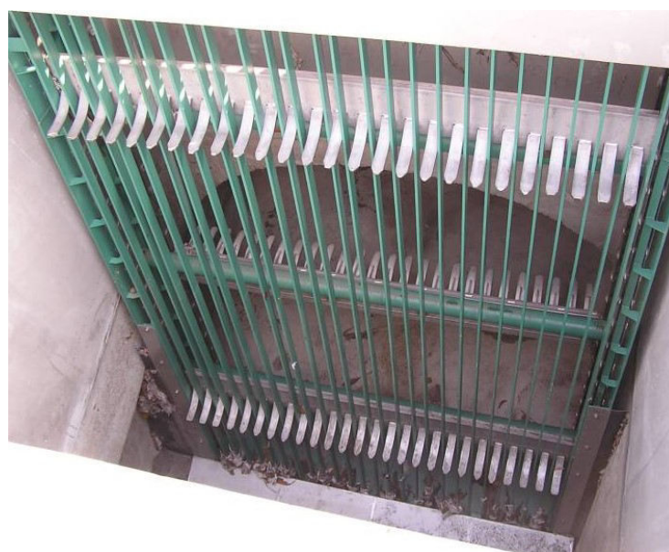
Obr. 6 Střední spodem stírané česle FONTANA R [4]
