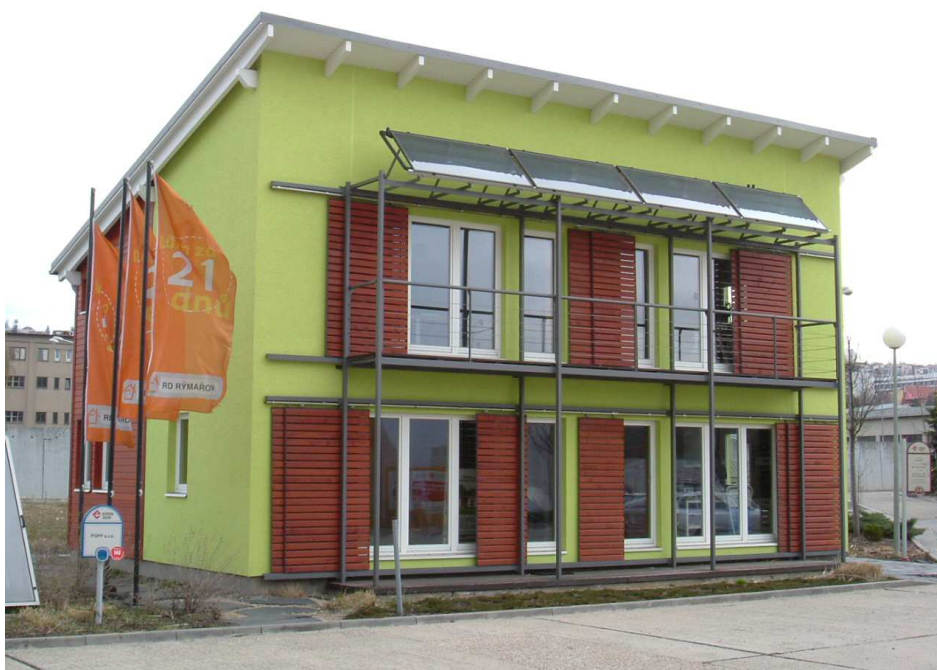
Obr 6-1 Pohled na dům od jihozápadu
