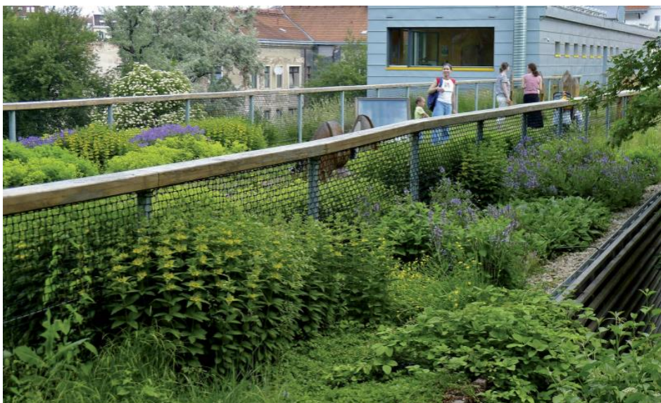
Obr. 2 - Příklad semiintenzivní zelené střechy [3]
