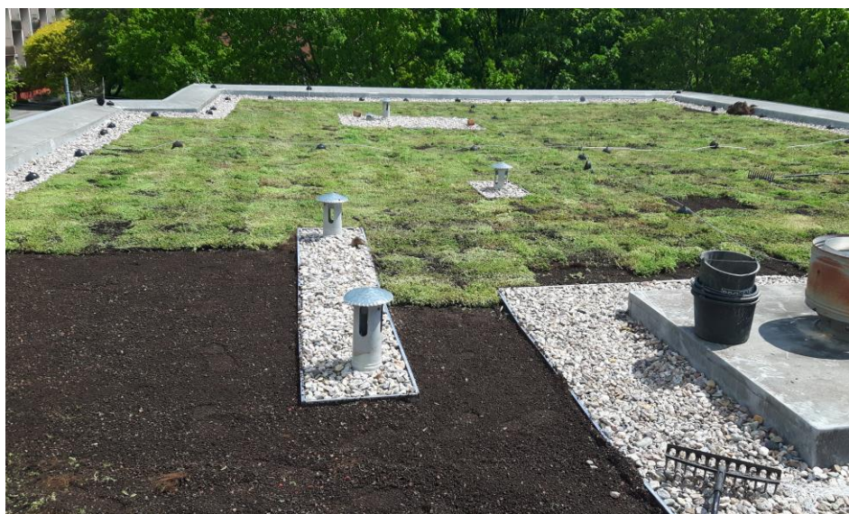
Obr. 1 - Příklad extenzivní zelené střechy [zdroj: autor, 2022]
