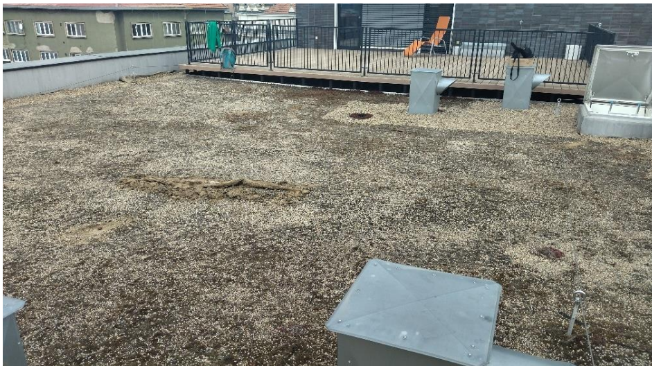
Obr. 15 - Původní stav extenzivní zelené střechy objektu Bratislavská 22 [zdroj: autor, 2022]
