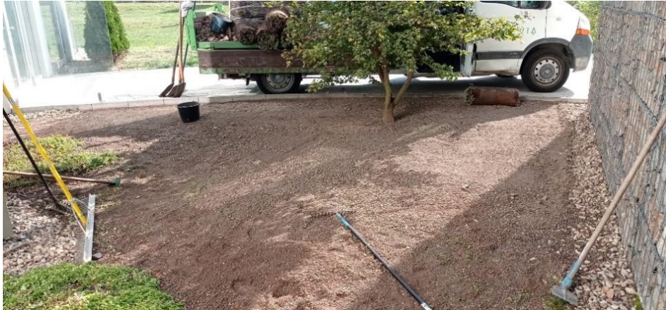
Obr. 52 - Příprava podkladu pro položení vegetační vrstvy [zdroj: autor, 2022]
