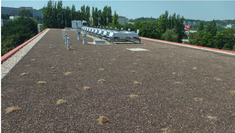
Obr. 17 - Extenzivní zelená střecha budovy Red Hat [zdroj: autor, 2022]
