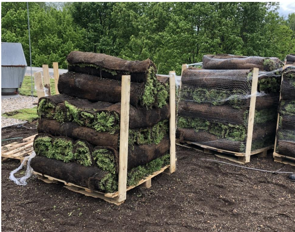
Obr. 11 - Příklad vegetační vrstvy ve formě předpěstovaných rozchodníkových koberců [zdroj: autor, 2021]
