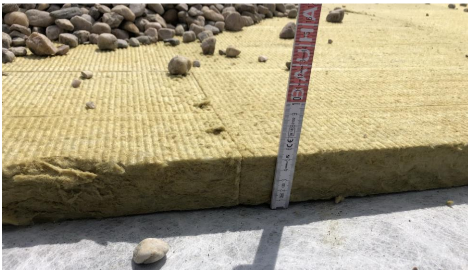
Obr. 7 - Hydroakumulační vrstva zelené střechy [zdroj: autor, 2021]
