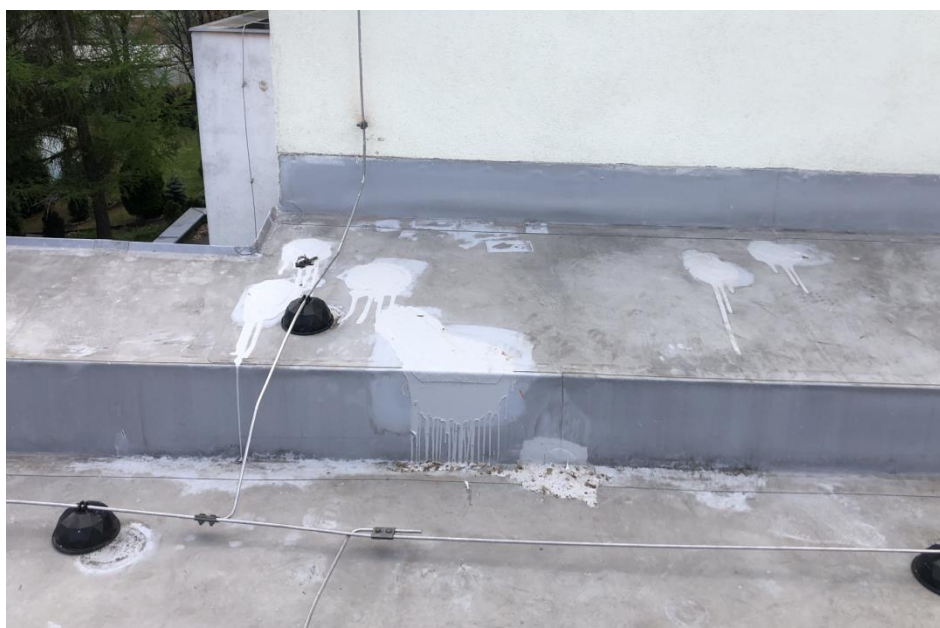
Obr. 13 - Rizikové body po opravě hydroizolace [zdroj: autor, 2021]
