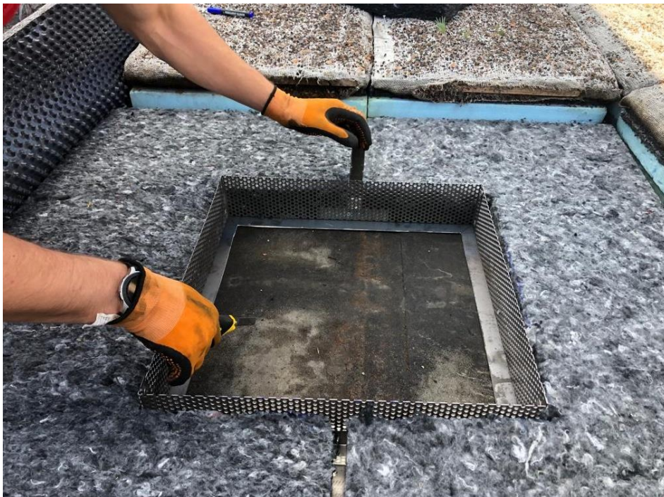
Obr. 25 - Kontrolní segment s hydroakumulační vrstvou [zdroj: autor, 2021]
