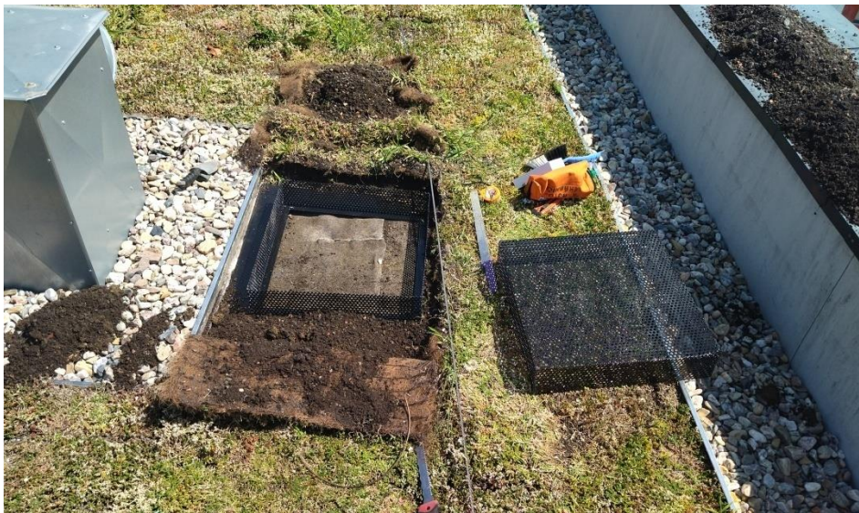
Obr. 30 - Implementace kontrolního segmentu na budově Bratislavská 22 [zdroj: autor, 2022]
