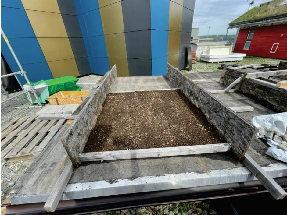
Obr. 55 - Dokončená zkušební střecha s finální vrstvou substrátu [zdroj: autor, 2023]
