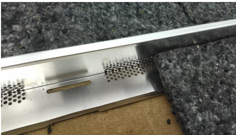
Obr. 45 - Hliníkové profily oddělující kamenivo a substrát [zdroj: autor, 2022]
