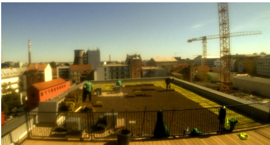
Obr. 47 - Kladení vegetačních koberců [zdroj: autor, 2022]
