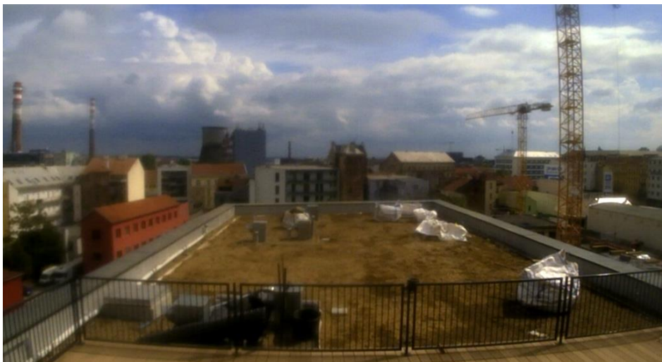
Obr. 46 - Střecha před dosypáním substrátu [zdroj: autor, 2022]
