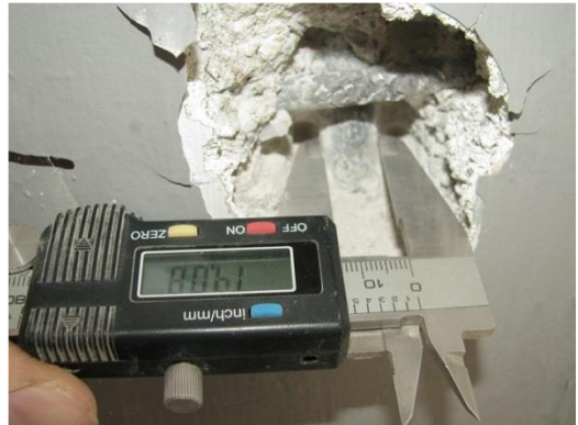
Obr. 93 Fotografie odhalené výztuže s měřením hloubky krycích vrstev
