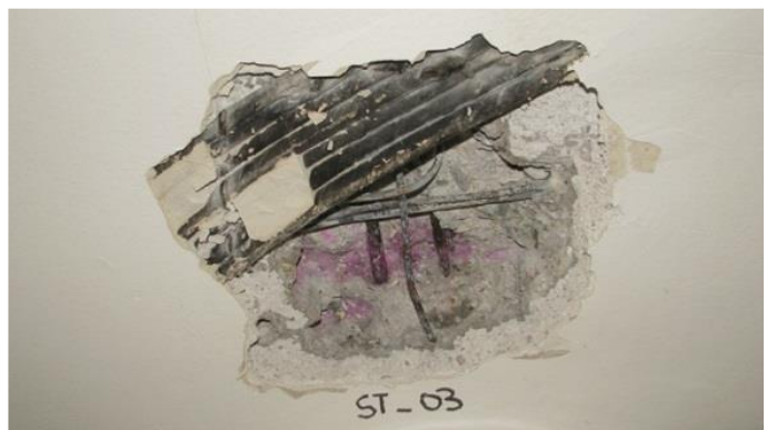
Obr. 116 Fotografie určení vyztužení spodní výztuže u krajní podpory zesíleného stropního žebra vynášejícího konstrukci z obvodového sloupu
