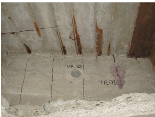
Obr. 66 Pohled na provedené odběrové místo v sondě O4 ve 3.NP
