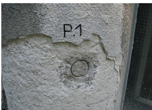
Obr. 145 PR(01) – obvodový sloup v 1.NP
