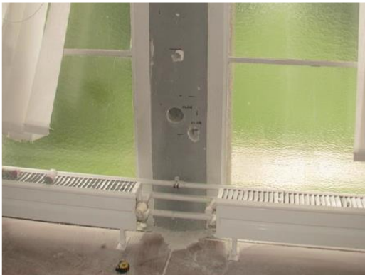
Obr. 50 Pohled na provedené odběrové místo obvodového sloupu ve 3.NP
