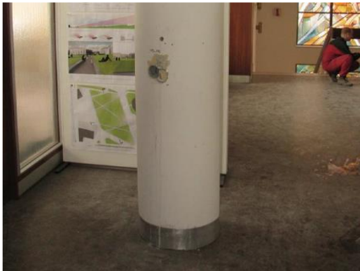
Obr. 44 Pohled na provedené odběrové místo vnitřního sloupu ve 2.NP
