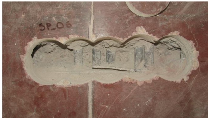
Obr. 104 Fotografie určení vyztužení stropního průvlaku na vyztužení nad vnitřními podporami
