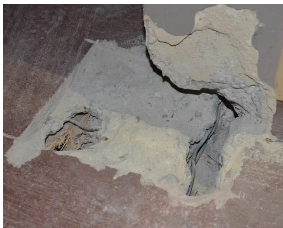
Obr. 157 Detail sekané sondy z horního líce v nadpodporovém průřezu příčného trámu (řez 2-2')
