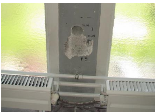
Obr. 153 PR(09) – obvodový sloup ve 3.NP
