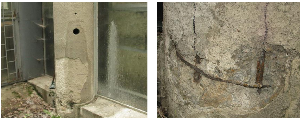
Obr. 29 vlevo – pohled na odběrné místo s označením VS(12) obvodového sloupu v 1.NP; vpravo – detail paty sloupu v místě sondy SS(12)
