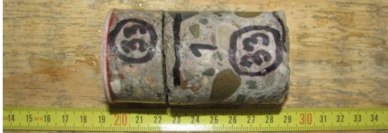
Obr. 143 Vzorek betonu \varnothing 50 mm sondy P(10)
