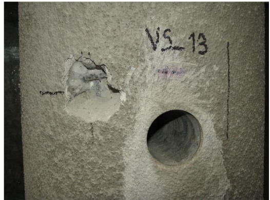
Obr. 98 Fotografie odhalené výztuže s měřením hloubky krycích vrstev
