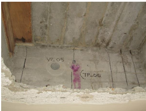
Obr. 70 Pohled na provedené odběrové místo v sondě O6 ve 3.NP
