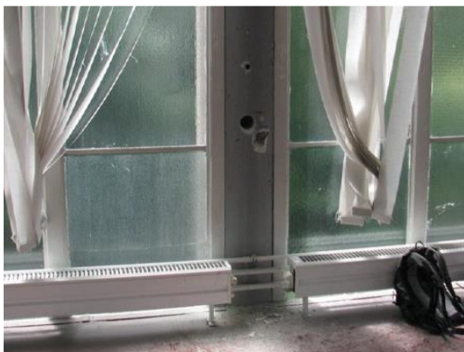
Obr. 46 Pohled na provedené odběrové místo obvodového sloupu ve 3.NP
