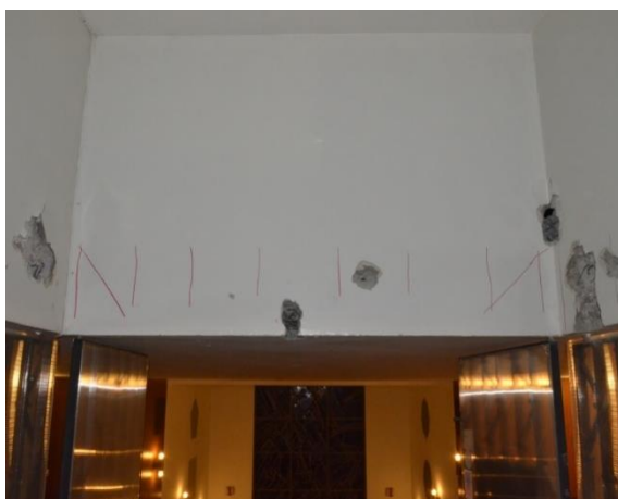
Obr. 28 Vlevo – pohled na příčný trám s rozkreslenou smykovou výztuží na povrchu s provedenými sekanými sondami, vpravo – pohled na schodišťový trám se sondami a rozkreslenou smykovou výztuží
