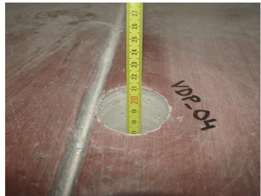
Obr. 132 Detail skladby v místě sondy P(04)
