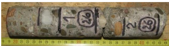
Obr. 129 Vzorek betonu Ø 50 mm sondy P(03)
