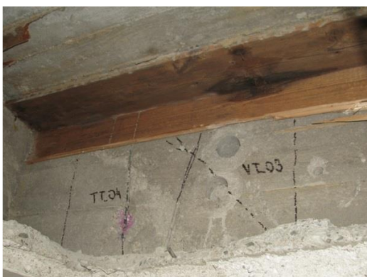
Obr. 78 Pohled na provedené odběrové místo v sondě O4 ve 3.NP
