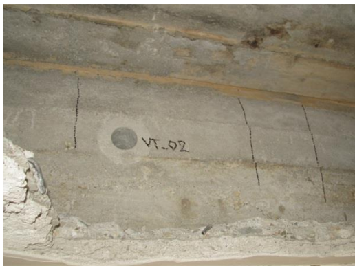
Obr. 76 Pohled na provedené odběrové místo v sondě O3 ve 3.NP
