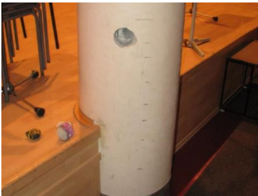
Obr. 38 Pohled na provedené odběrové místo vnitřního sloupu v 1.NP
