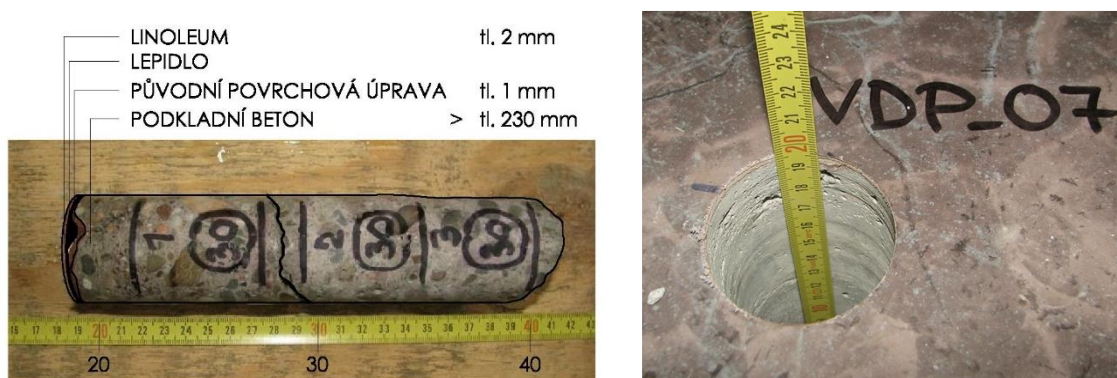
Obr. 30 vlevo – vzorek betonu \varnothing 50 mm sondy P(07) se skladbou; vpravo – detail skladby v místě sondy
