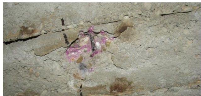
Obr. 122 Fotografie spodní výztuže stropní desky na místě s označením SD(02)
