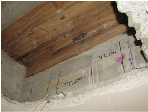
Obr. 80 Pohled na provedené odběrové místo v sondě O5 ve 3.NP
