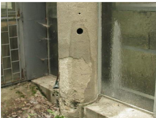
Obr. 58 Pohled na provedené odběrové místo obvodového sloupu v 1.NP
