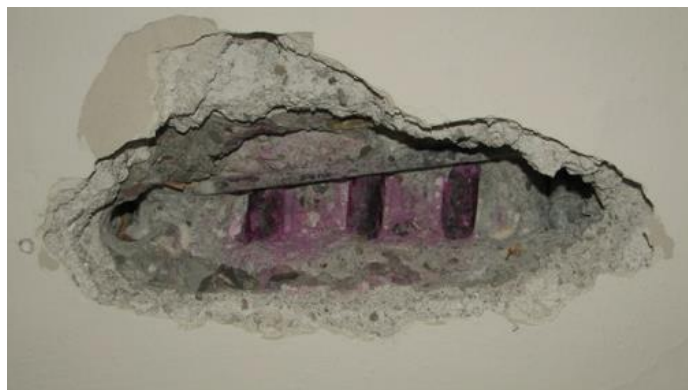
Obr. 101 Fotografie určení vyztužení střešního průvlaku uprostřed rozpětí vnitřního pole na ohybový moment u dolního líce
