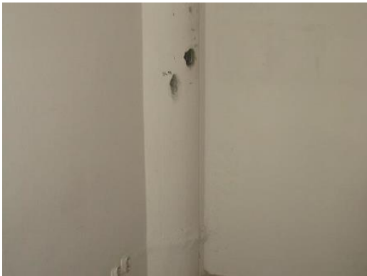
Obr. 56 Pohled na provedené odběrové místo vnitřního sloupu ve 2.NP
