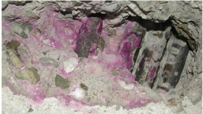
Obr. 108 Fotografie určení vyztužení stropního průvlaku uprostřed rozpětí ve středním poli
