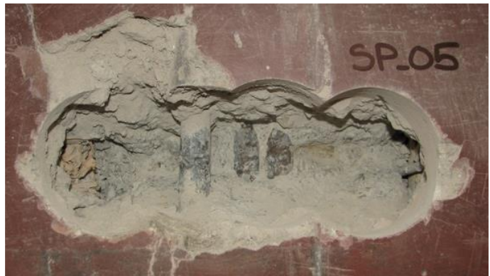
Obr. 103 Fotografie určení vyztužení stropního průvlaku uprostřed rozpětí na ohybový moment u dolního líce
