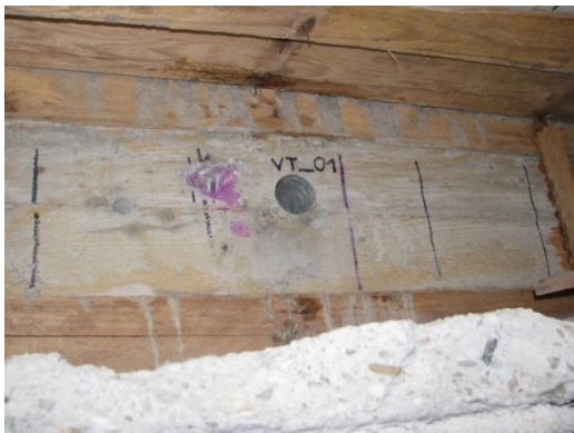
Obr. 74 Pohled na provedené odběrové místo v sondě O1 v 1.NP
