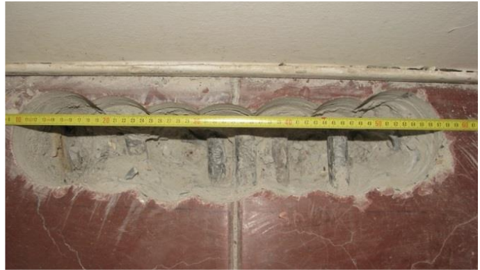
Obr. 102 Fotografie vyztužení stropního průvlaku vykonzolovaného schodišťového prvku nad vnitřní podporou
