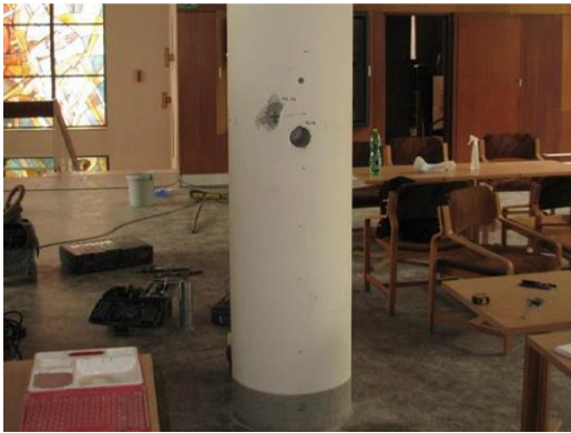
Obr. 54 Pohled na provedené odběrové místo vnitřního sloupu ve 2.NP
