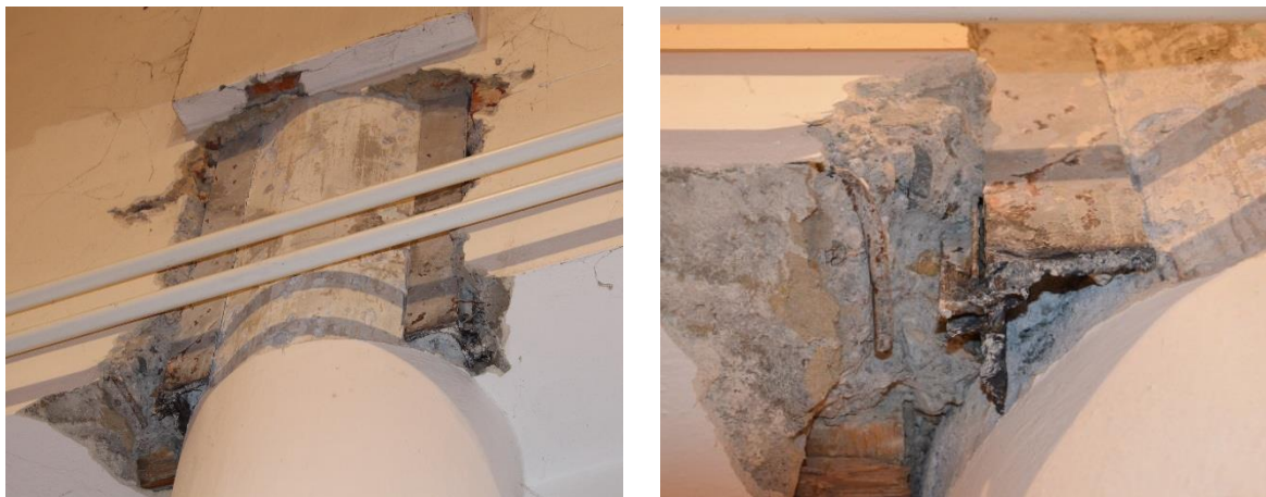
Obr. 34 Vlevo – pohled na sekanou sondu k detailu napojení dodatečného stropního železobetonového průvzlaku k původním nosným sloupům, vpravo – detail ocelového L profilu
