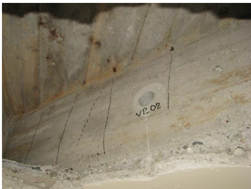
Obr. 64 Pohled na provedené odběrné místo v sondě O3 ve 3.NP
