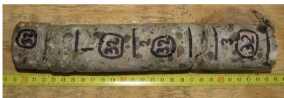
Obr. 141 Vzorek betonu Ø 50 mm sondy P(09)
