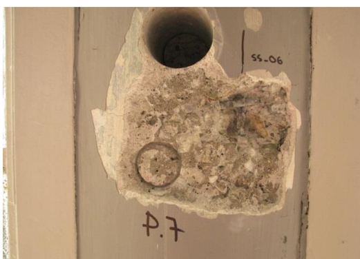
Obr. 151 PR(07) – obvodový sloup ve 3.NP
