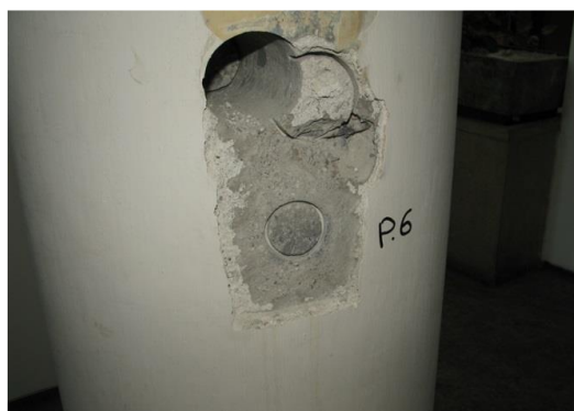
Obr. 150 PR(06) – vnitřní nosný sloup ve 2.NP
