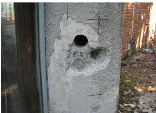
Obr. 147 PR(03) – obvodový sloup v 1.NP
