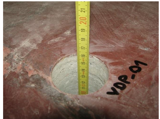
Obr. 126 Detail skladby v místě sondy P(01)
