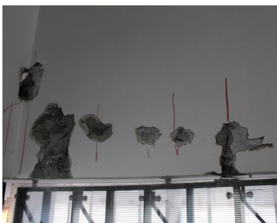
Obr. 158 Pohled na schodišťový trám se sondami a rozkreslenou smykovou výztuží
