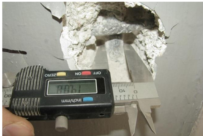
Obr. 8 Určení vyztužení sloupu sekanou sondou
