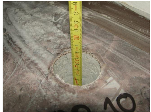
Obr. 144 Detail skladby v místě sondy P(10)
