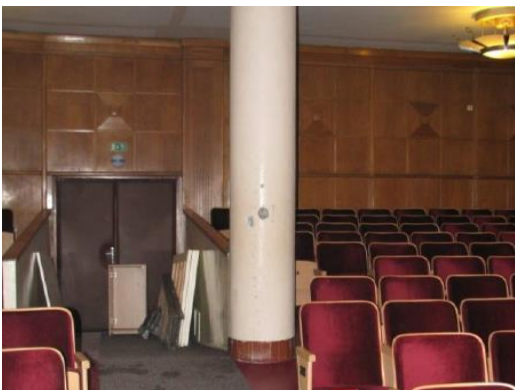
Obr. 40 Pohled na provedené odběrové místo vnitřního sloupu v 1.NP
