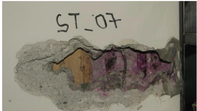
Obr. 120 Fotografie určení vyztužení spodní výztuže uprostřed rozpětí stropního žebra vynášejícího původního schodišťového tělesa
