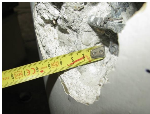
Obr. 96 Fotografie odhalené výztuže s měřením hloubky krycích vrstev
