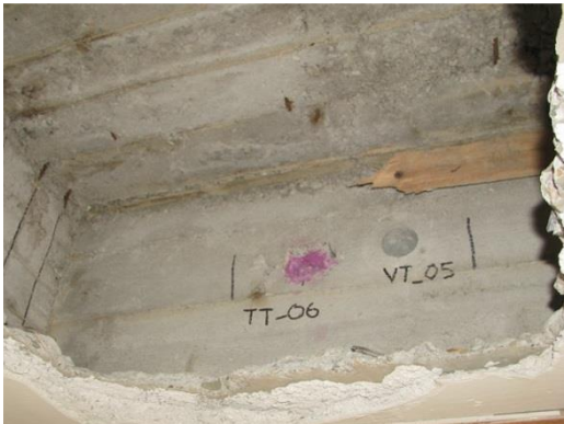
Obr. 82 Pohled na provedené odběrové místo v sondě O6 ve 3.NP
