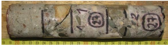
Obr. 131 Vzorek betonu Ø 50 mm sondy P(04)
