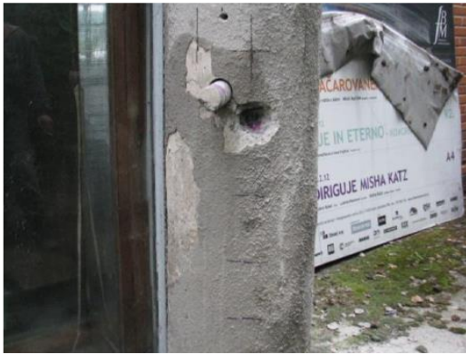
Obr. 42 Pohled na provedené odběrové místo obvodového sloupu v 1.NP (venkovní odběr)
