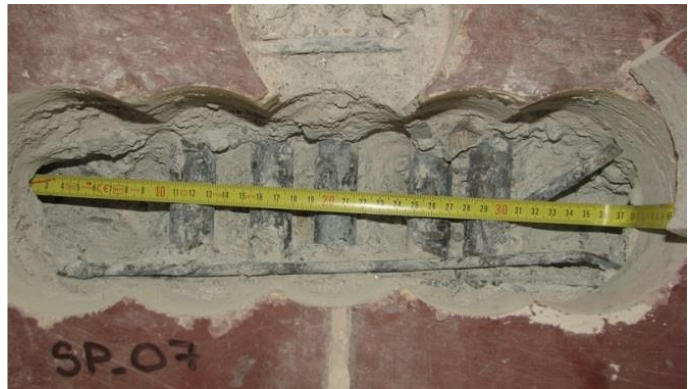
Obr. 105 Fotografie určení vyztužení stropního průvlaku na vyztužení nad vnitřními podporami
