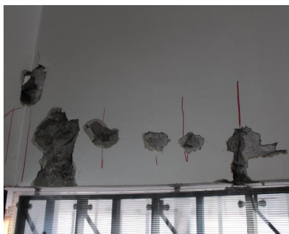
Obr. 28 Vlevo – pohled na příčný trám s rozkreslenou smykovou výztuží na povrchu s provedenými sekanými sondami, vpravo – pohled na schodišťový trám se sondami a rozkreslenou smykovou výztuží
