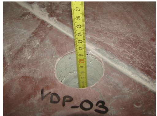
Obr. 130 Detail skladby v místě sondy P(03)
