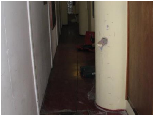
Obr. 36 Pohled na provedené odběrové místo obvodového sloupu v 1. NP
