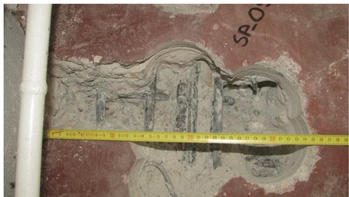
Obr. 107 Fotografie určení vyztužení stropního žebra vynášejícího u krajní podpory konstrukci včetně určení vyztužení krajního stropního průvlaku nad vnitřní podporou
