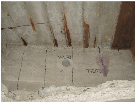
Obr. 68 Pohled na provedené odběrové místo v sondě O4 ve 3.NP
