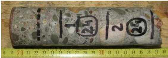
Obr. 125 Vzorek betonu Ø 50 mm sondy P(01)
