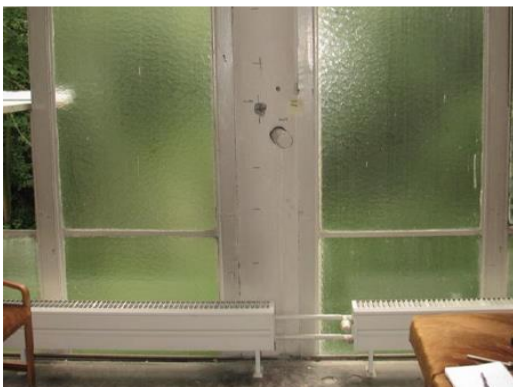
Obr. 52 Pohled na provedené odběrové místo obvodového sloupu ve 2.NP
