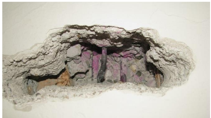
Obr. 115 Fotografie určení vyztužení spodní výztuže uprostřed rozpětí zesíleného střešního žebra vynášejícího konstrukci z obvodového sloupu
