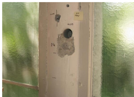
Obr. 148 PR(04) – obvodový sloup ve 2.NP
