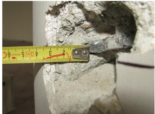
Obr. 92 Fotografie odhalené výztuže s měřením hloubky krycích vrstev
