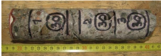
Obr. 137 Vzorek betonu Ø 50 mm sondy P(07)
