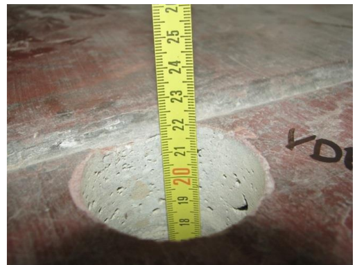
Obr. 128 Detail skladby v místě sondy P(02)
