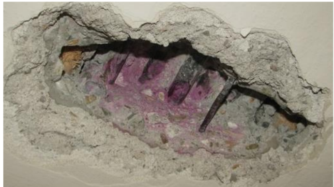
Obr. 114 Fotografie určení vyztužení spodní výztuže uprostřed rozpětí zesíleného střešního žebra vynášejícího konstrukci z obvodového sloupu
