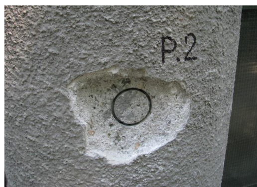
Obr. 146 PR(02) – obvodový sloup v 1.NP
