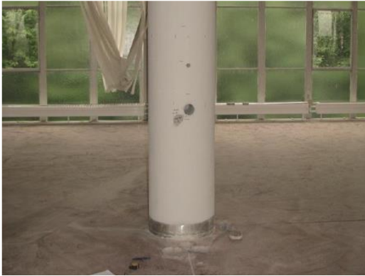
Obr. 48 Pohled na provedené odběrové místo vnitřního sloupu ve 3.NP
