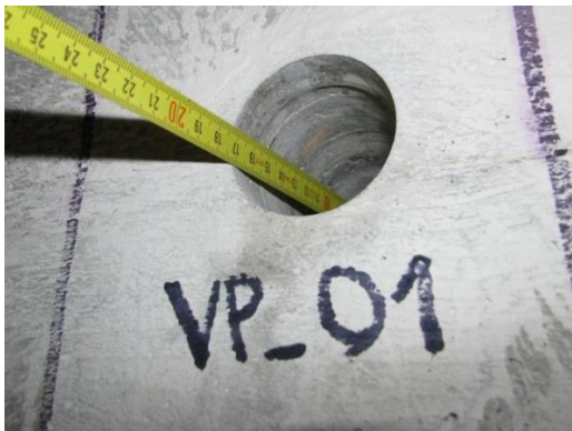
Obr. 62 Pohled na provedené odběrové místo v sondě O1 v 1.NP
