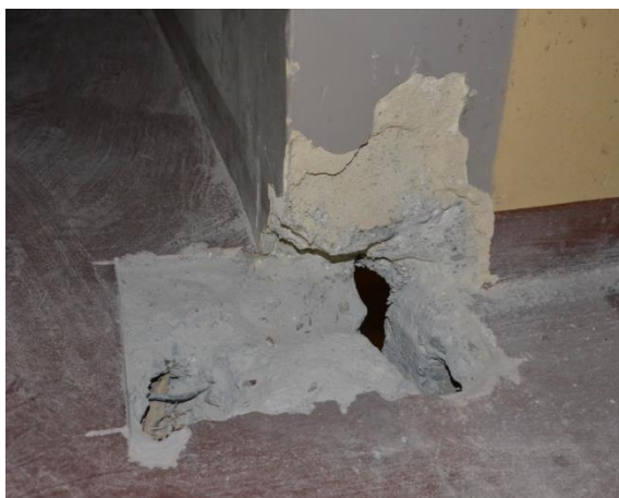
Obr. 156 Pohled na sondu z horního líce stropní konstrukce ve styku příčného trámu s trámem schodišťovým (řez 2-2')
