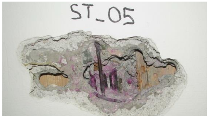
Obr. 118 Fotografie určení vyztužení spodní výztuže uprostřed rozpětí zesíleného stropního žebra vynášejícího konstrukci z obvodového sloupu
