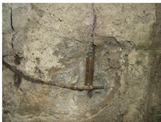
Obr. 97 Fotografie odhalené výztuže s měřením hloubky krycích vrstev
