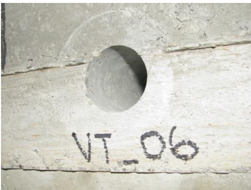
Obr. 84 Pohled na provedené odběrové místo v sondě O2 v 1.NP
