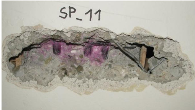
Obr. 109 Fotografie určení vyztužení stropního průvlaku uprostřed rozpětí ve středním poli
