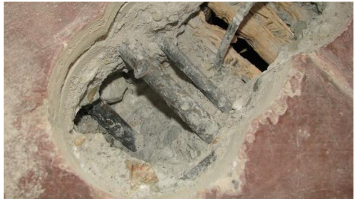
Obr. 106 Fotografie určení vyztužení stropního žebra u vnitřní podpory
