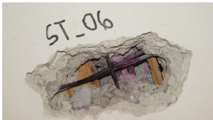
Obr. 119 Fotografie určení vyztužení spodní výztuže uprostřed rozpětí klasického stropního žebra
