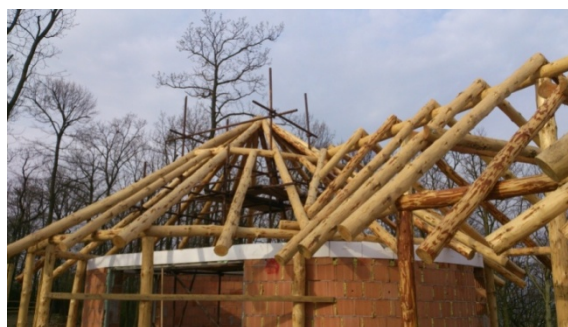
Obrázek 9.1.2: Ukázka konstrukce krovu na objektu č.3 ZOO Brno – Africká vesnice
