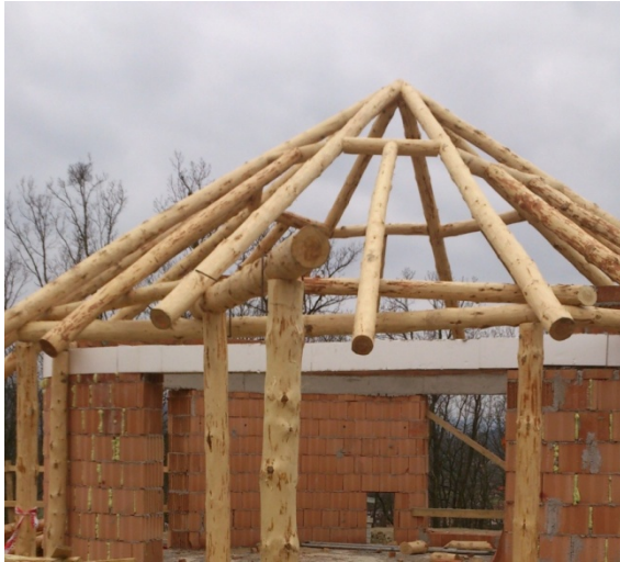
Obrázek 9.1.4: Ukázka konstrukce krovu na objektu č.11 ZOO Brno – Africká vesnice
