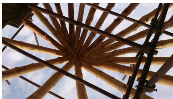
Obrázek 9.1.3: Ukázka styku devatenácti krokví ve vrcholu krovu na objektu č.3 ZOO Brno – Africká vesnice
