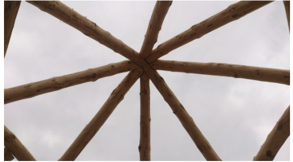
Obrázek 9.1.5: Ukázka styku osmi krokví ve vrcholu krovu na objektu č.11 ZOO Brno – Africká vesnice
