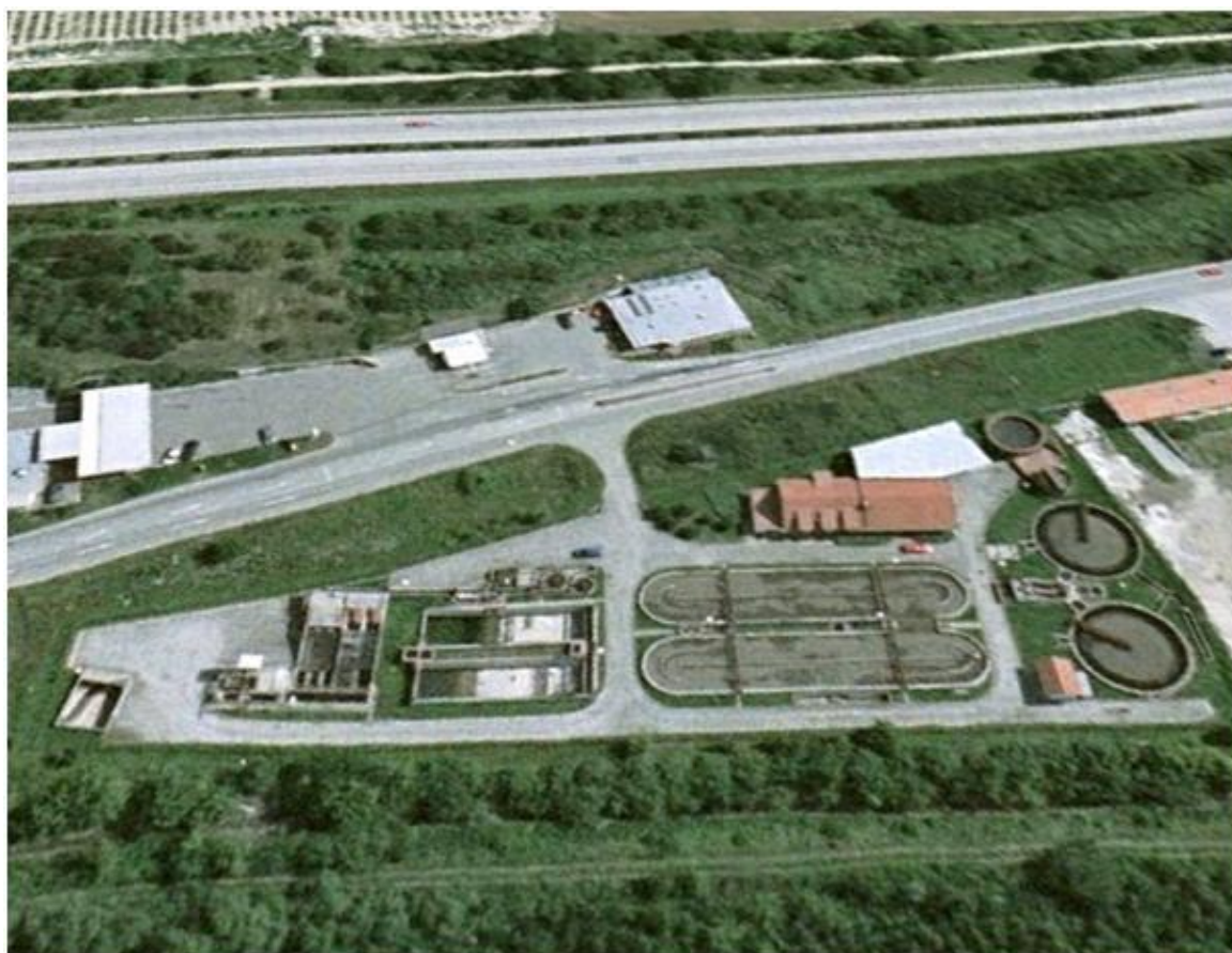
Obr. 3: Čistírna odpadních vod v Hustopečích [18].
