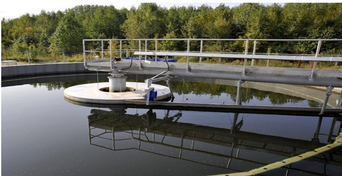
Obr. 8: Dosazovací nádrž po rekonstrukci [16].
