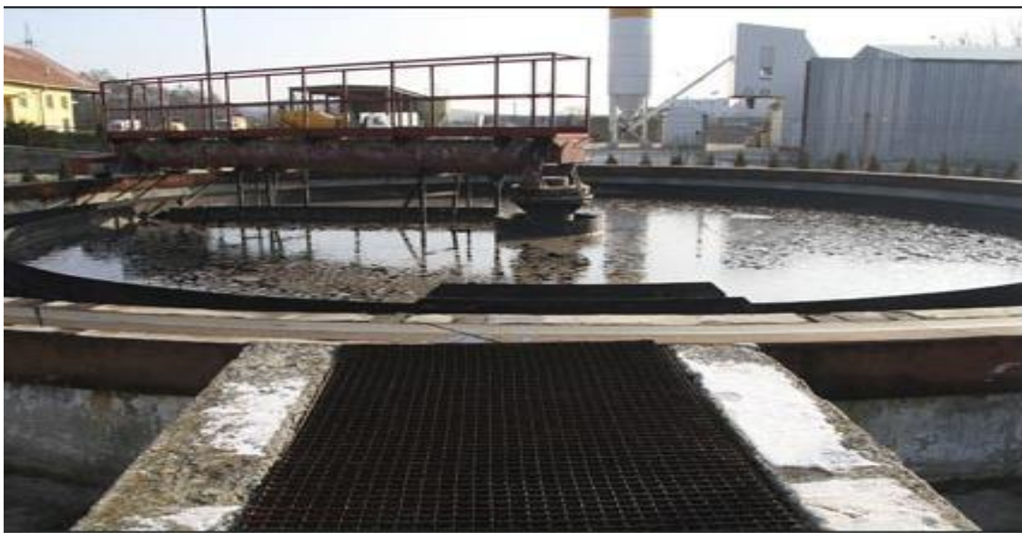
Obr. 7: Dosazovací nádrž před rekonstrukcí [16].
