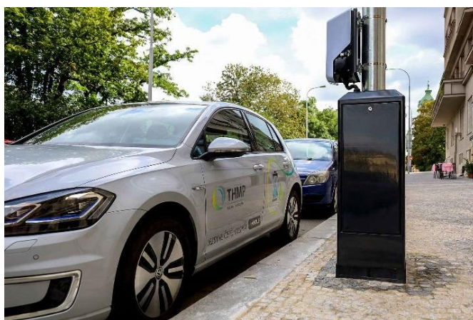
Obrázek 3.5 Dobíjení elektrických automobilů pomocí infrastruktury veřejného osvětlení [85]
