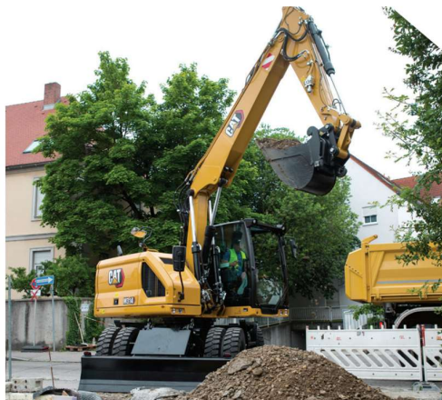
Obr. 32 Kolové rypadlo Cat M314, zdroj: [7]
