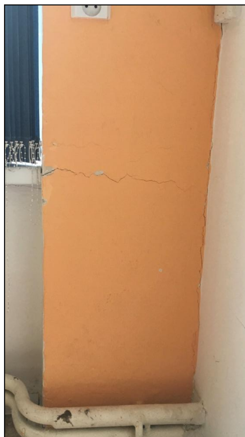
Obr. 26: Ohybem namáhaný sloup
