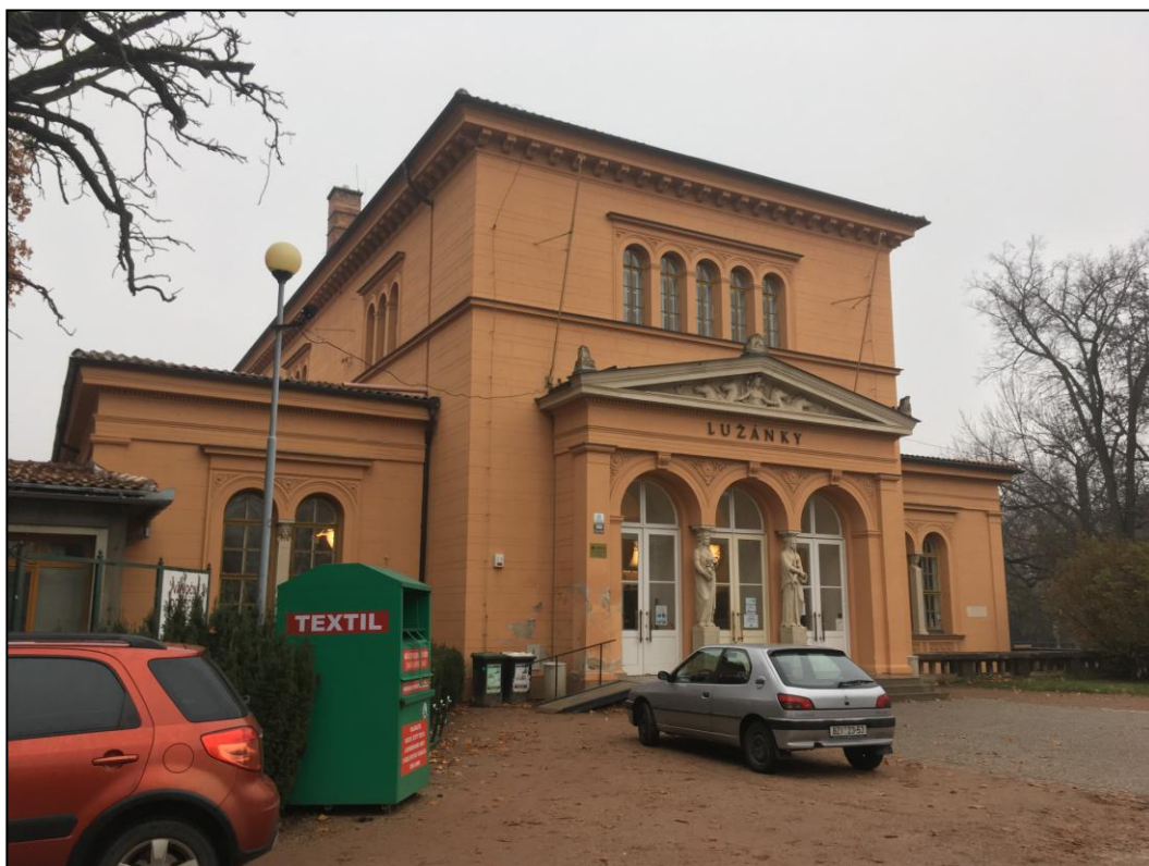
Obr. 5: Pohled na hlavní vstup bývalého domu pionýrů
