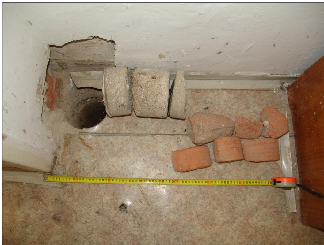
Obr. 35: Vrt P1 – složení konstrukce podlahy [23]
