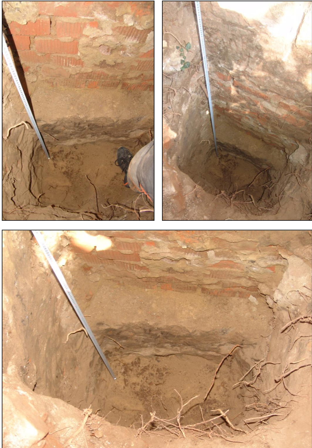
Obr. 40, 41, 42: Pohledy na kopanou sondu a způsob založení [23]
