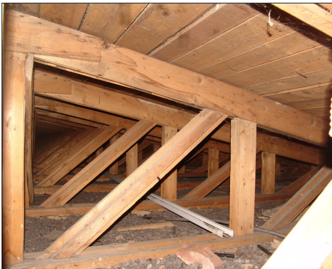
Obr. 17: Pohled na konstrukci krovu [23]
