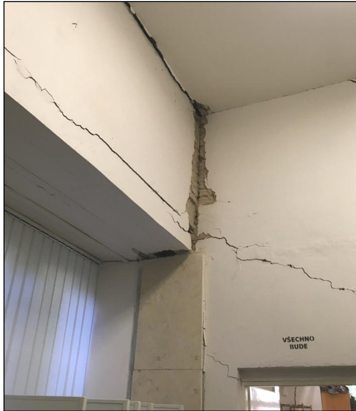
Obr. 21, 22: Pohledy na rozsáhlé trhliny v oblasti arkýře
