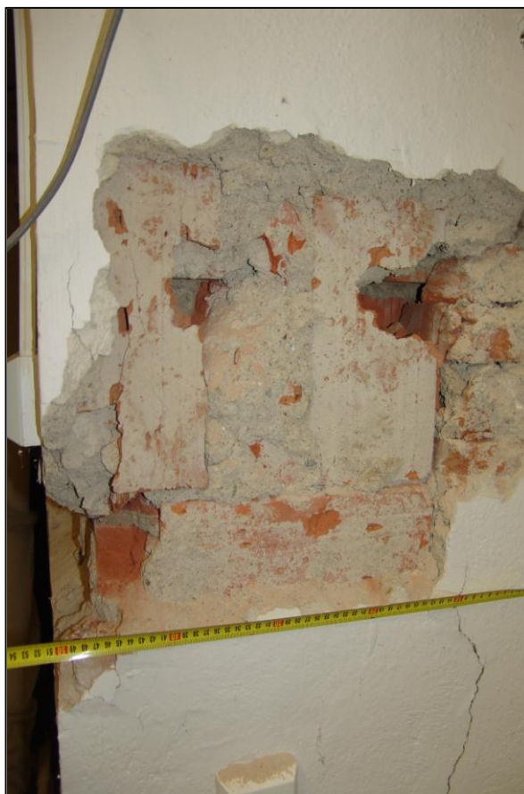
Obr. 18: Sekaná sonda v interiéru na obvodovém zdivu [23]
