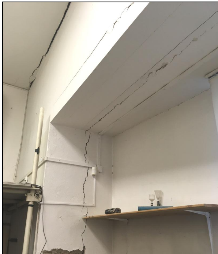
Obr. 21, 22: Pohledy na rozsáhlé trhliny v oblasti arkýře
