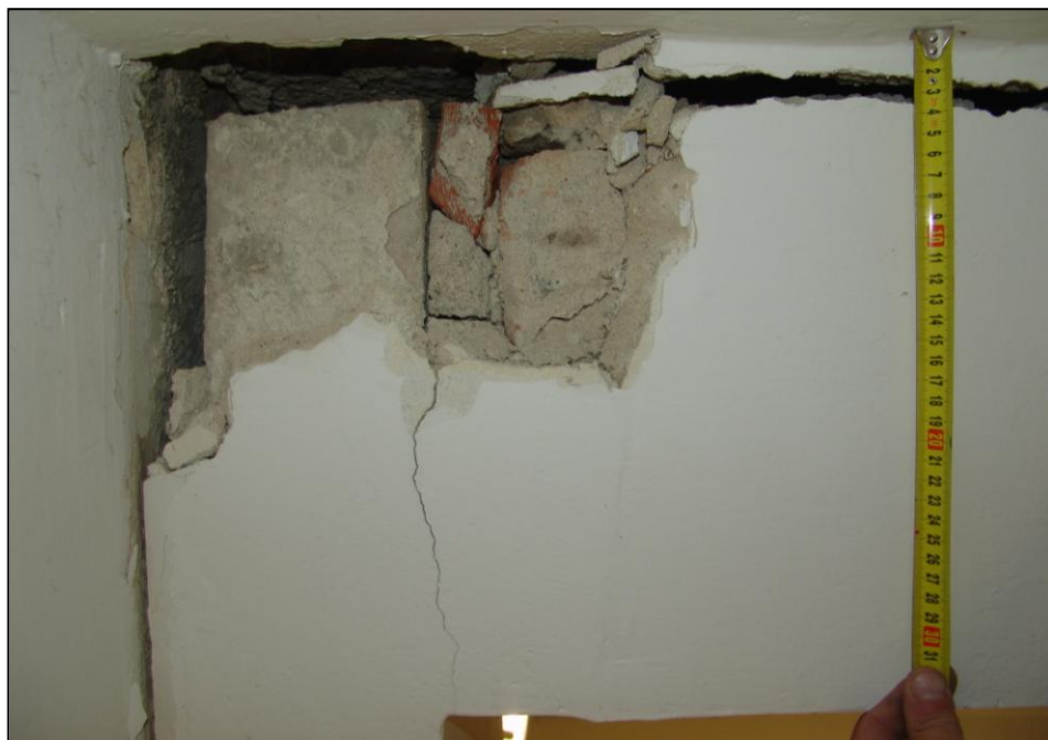
Obr. 13: Sekaná sonda na pomezí pilíře a stropu [23]
