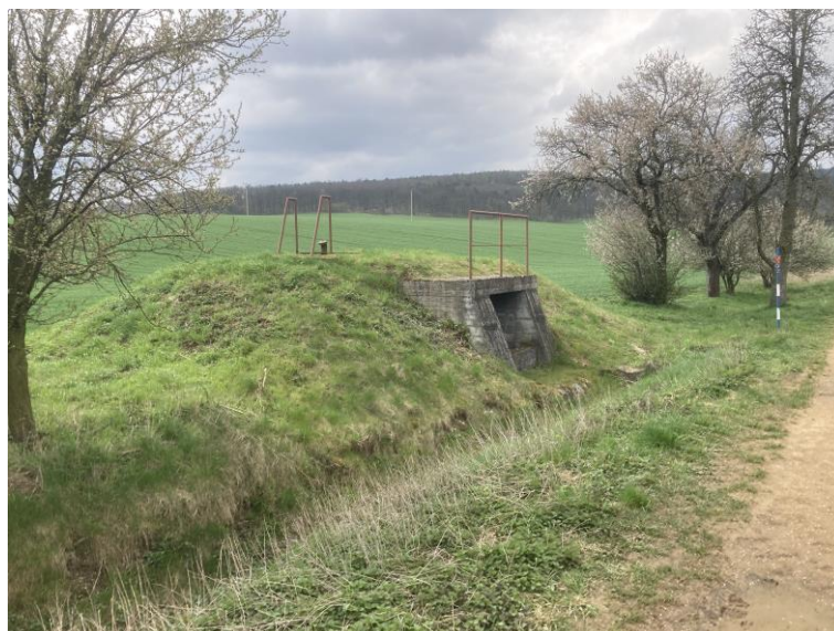
Obrázek 16 Objekt Vírského vodovodu v povodí KP5
