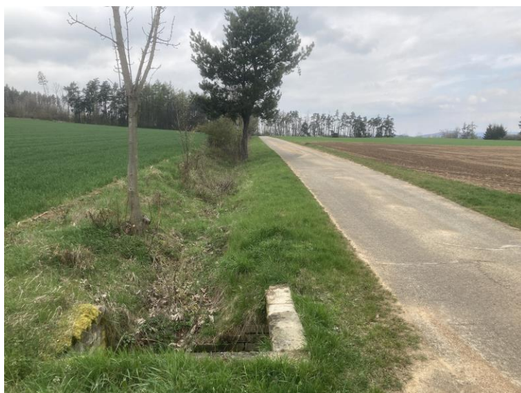
Obrázek 21 KP8 příkop podél cesty s propustkem
