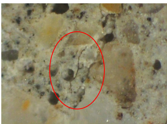
Obr. č. 94: Mikrotrhlina v cementovém tmelu po 200 °C
