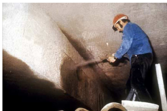
Obr. č. 10: Oprava betonové konstrukce pomocí torkretu – nástřik betonu [37]
