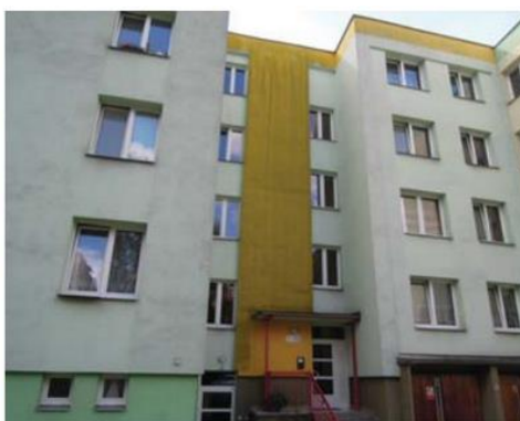
PŘED SANACÍ FASÁDY
