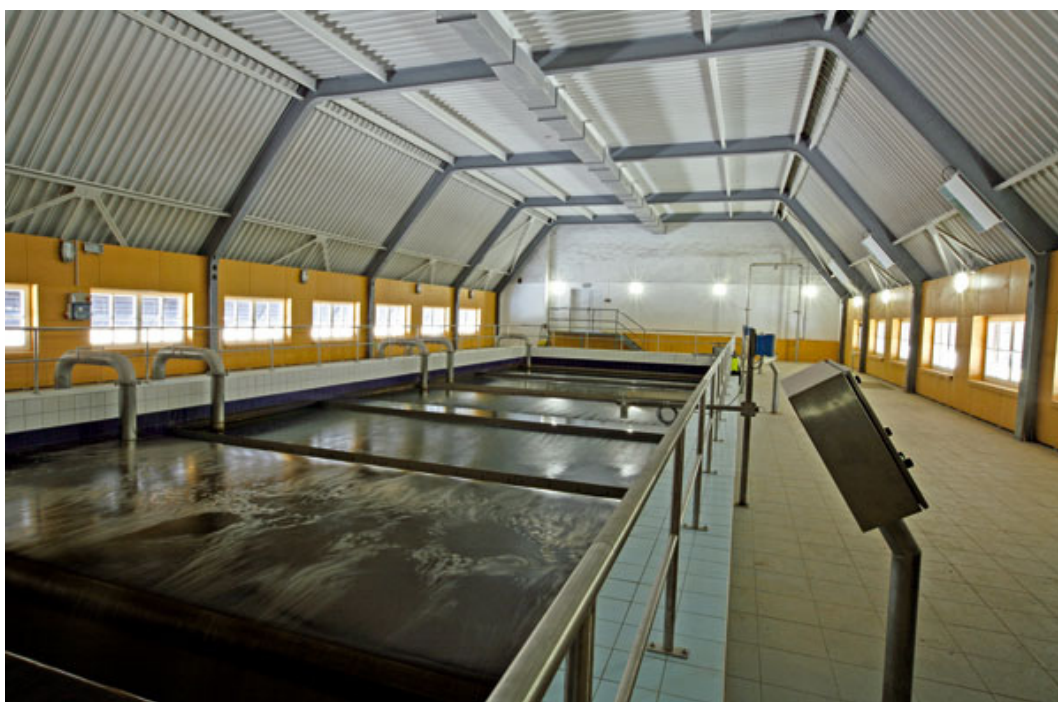
Obr. 6.44 ÚV Souš – hala filtrů [zdroj: www.asb-portal.cz ]
