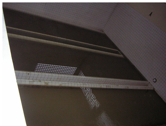
Obr. 6.8 ÚV Mostiště – pískové filtry
