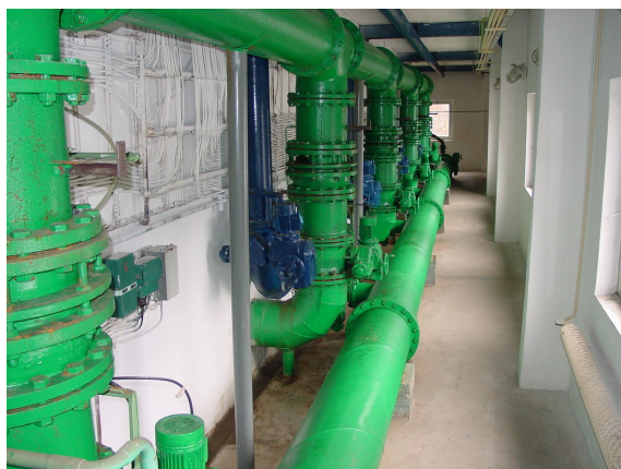
Obr. 6.12 ÚV Vír – rozvody pod filtry
