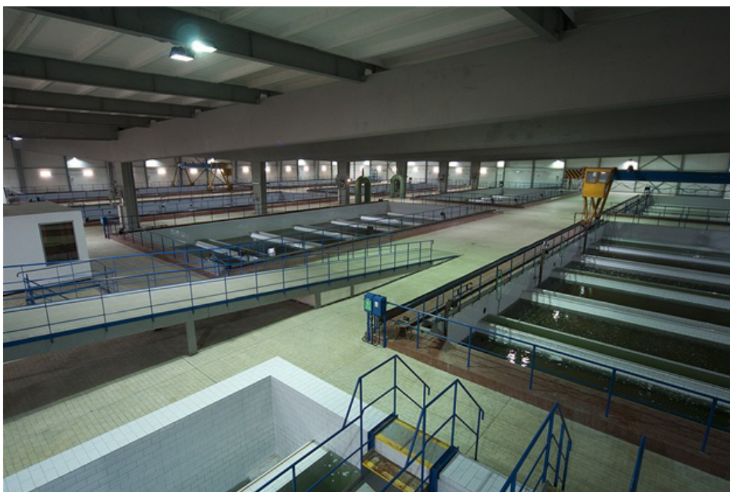
Obr. 6.24 ÚV Želivka – hala filtrů [zdroj: www.praha.idnes.cz ]
