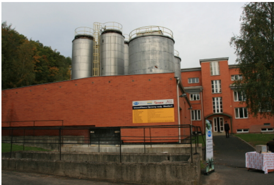
Obr. 6.41 ÚV Meziboří – celkový pohled [zdroj: www.sweco.cz ]
