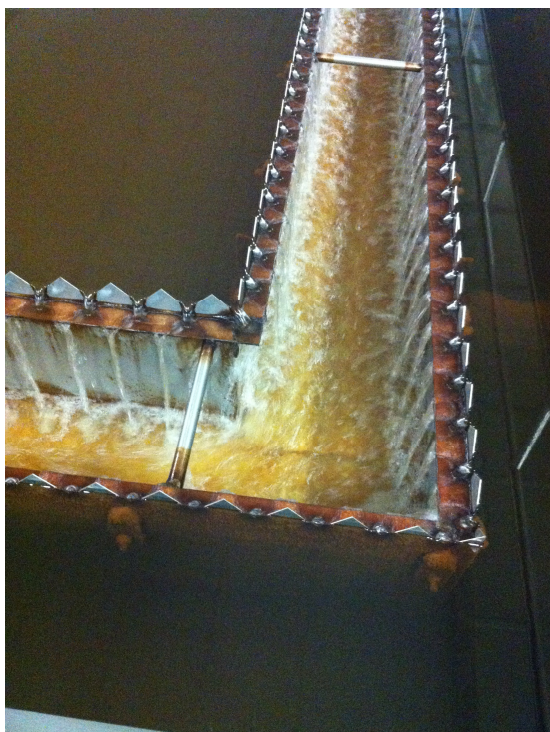
Obr. 5.4 ÚV Kroměříž – odtok. žlab
