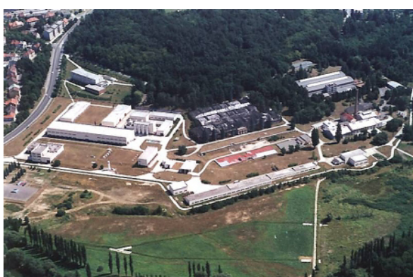
Obr. 6.14 ÚV Plzeň – letecký pohled
