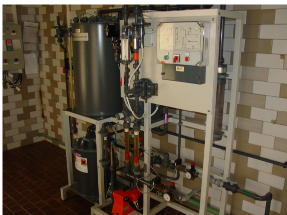
Obr. 6.9 ÚV Vír – dávkování chlordioxinu
