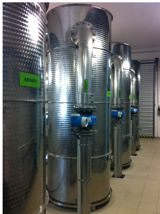
Obr. 5.5 ÚV Kroměříž – aerační věže
