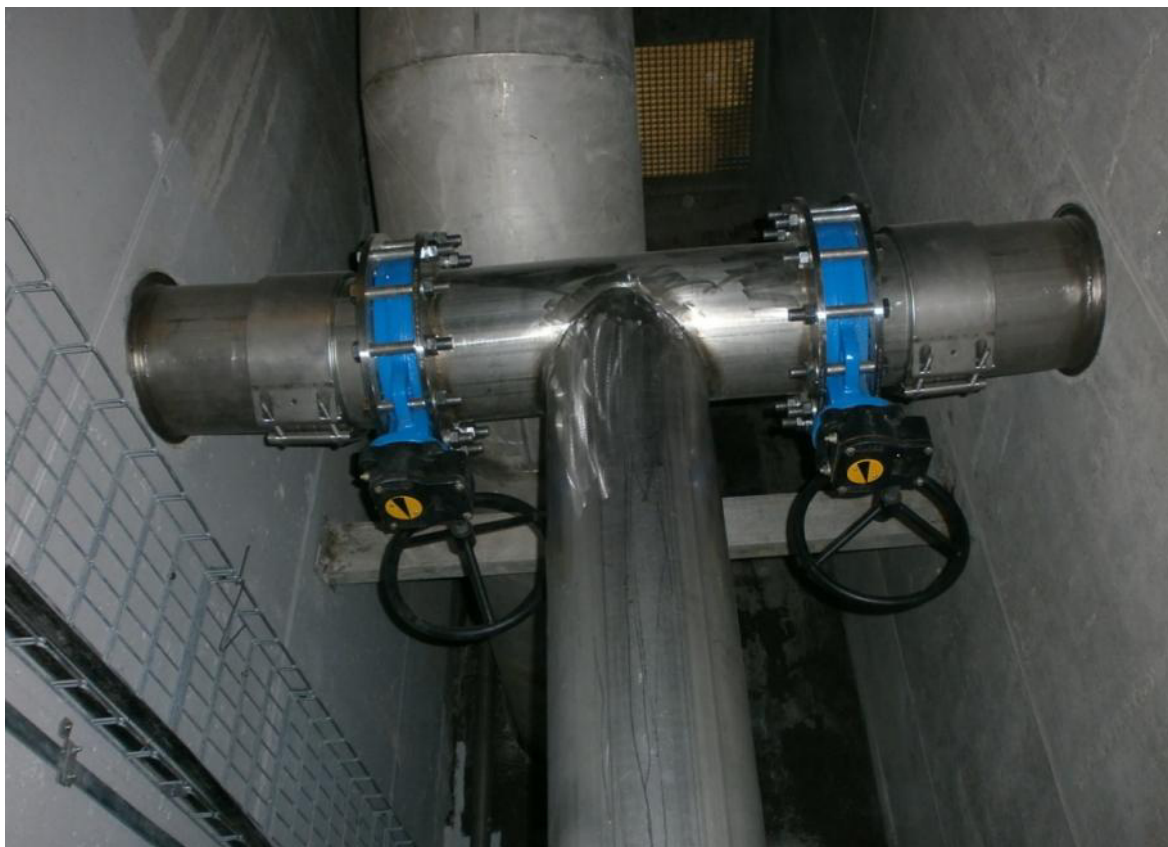
Obr. 6.37 ÚV Jirkov – vstrojení úpravní
