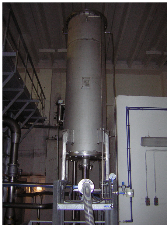
Obr. 6.6 ÚV Mostiště – saturátor
