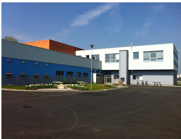
Obr. 6.18 ÚV Kroměříž – areál úpravny
