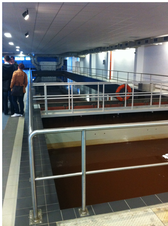
Obr. 6.17 ÚV Kroměříž – flokulace, sedimentace
