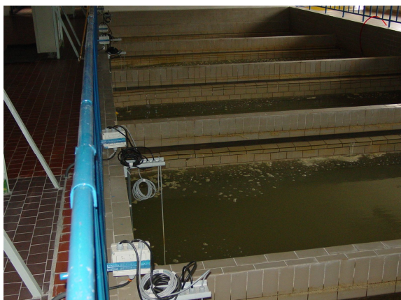
Obr. 6.11 ÚV Vír – pískové filtry
