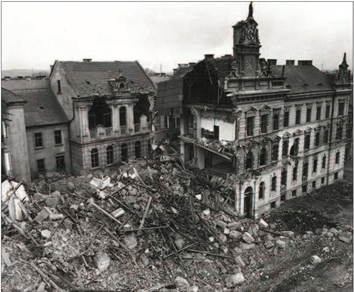
Obr. 17 Demolice starého Mostu v roce 1977 [16]
