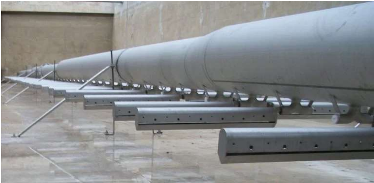
Obrázek 2-6 – Ilustrativní obrázek hrubobublinného aeračního systému [10]
