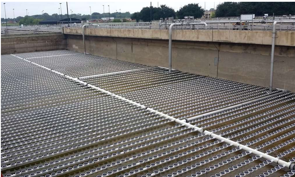
Obrázek 2-3- Ilustrativní obrázek jemnobublinného aeračního systému [10]
