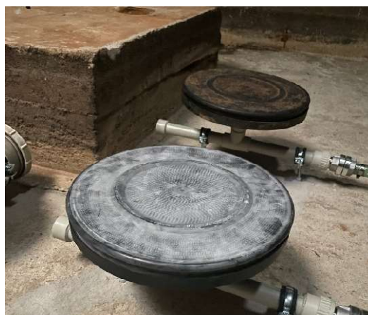
Obrázek 3-4 – Aerační element ENVICON EMS 12"
