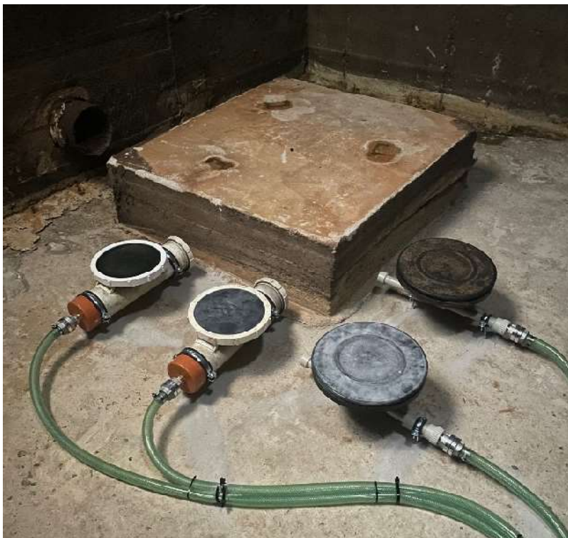
Obrázek 3-15 – Umístění aeračních elementů v nádrži
