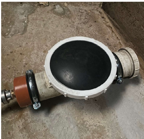
Obrázek 3-6 – Aerační element XYLEM SILVER SANITAIRE SERIES II
