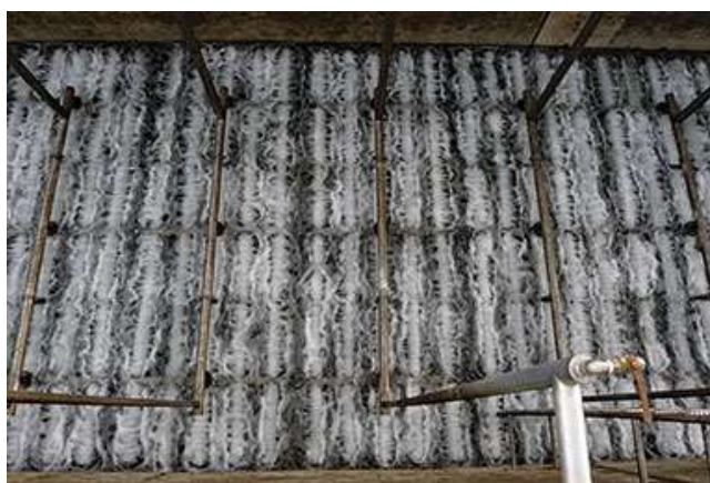
Obrázek 2-21 – Aerační systém využívající trubkové aerátory [24]
