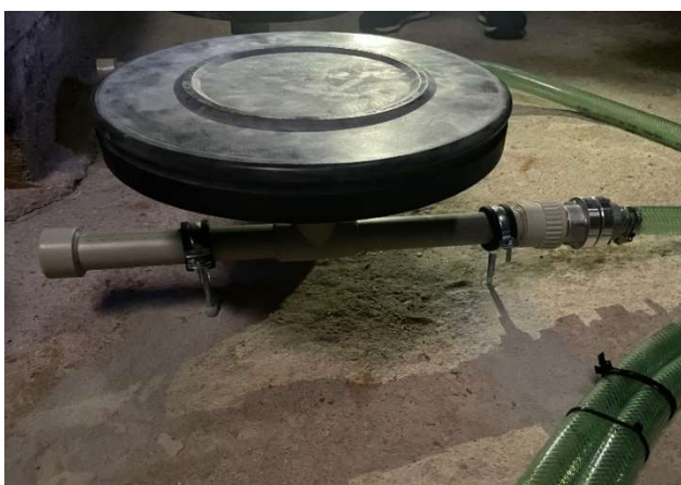
Obrázek 3-3 – Aerační element ENVICON EMS 12"
