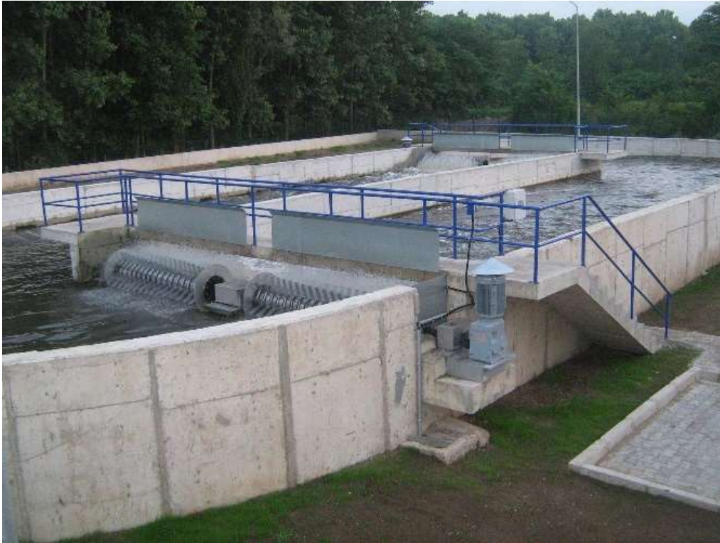
Obrázek 2-11 – Aplikace povrchového provzdušňovače s horizontální osou (Kessener) [15]
